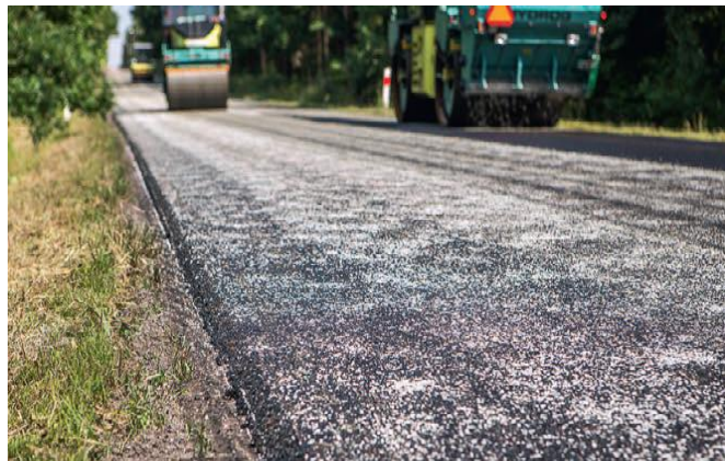
Remont drogi w Świerkłańcu DW 912
