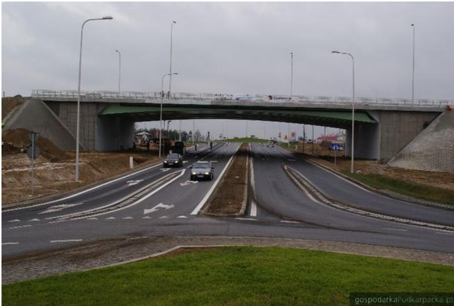
Wiadukt zintegrowany w ciągu S-19 k/Rzeszowa
