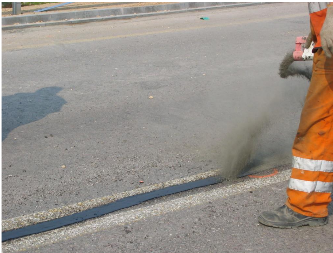
Posypywanie piaskiem bazaltowym
