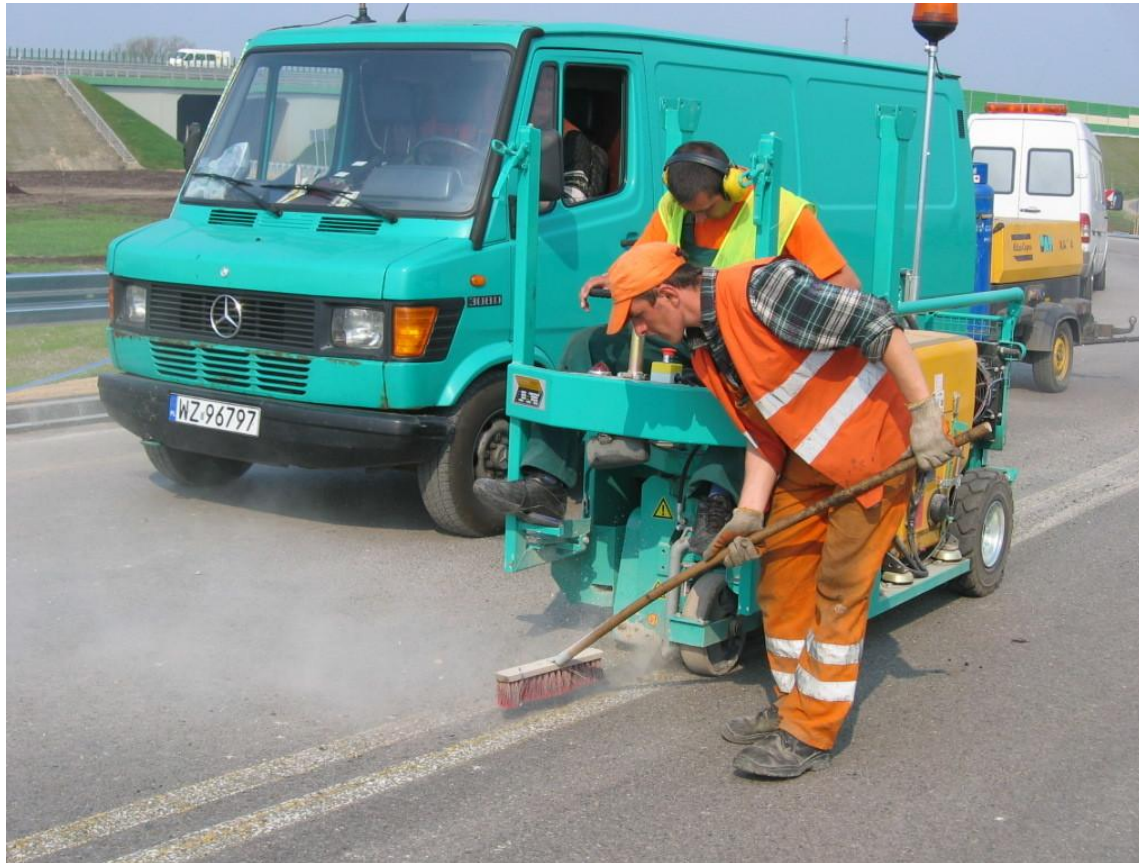
Frezowanie pęknięcia
