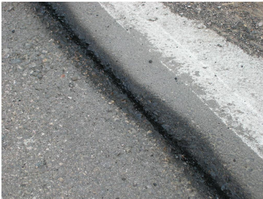
Szczelina gotowa do zalewania
