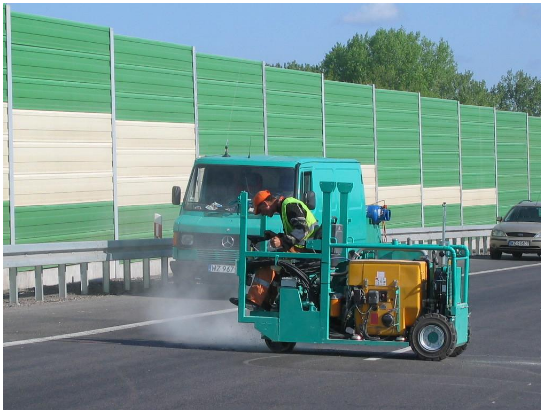
Frezowanie szczeliny
