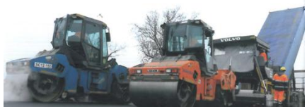
Roboty drogowe z wykorzystaniem asfaltu modyfikowanego gumą (AMG) w Warszawie w Pruszkowie
