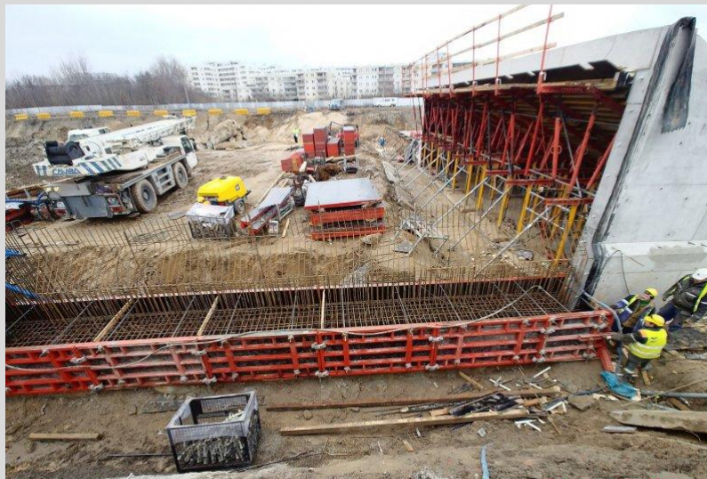
Portal wlotowy tunelu
