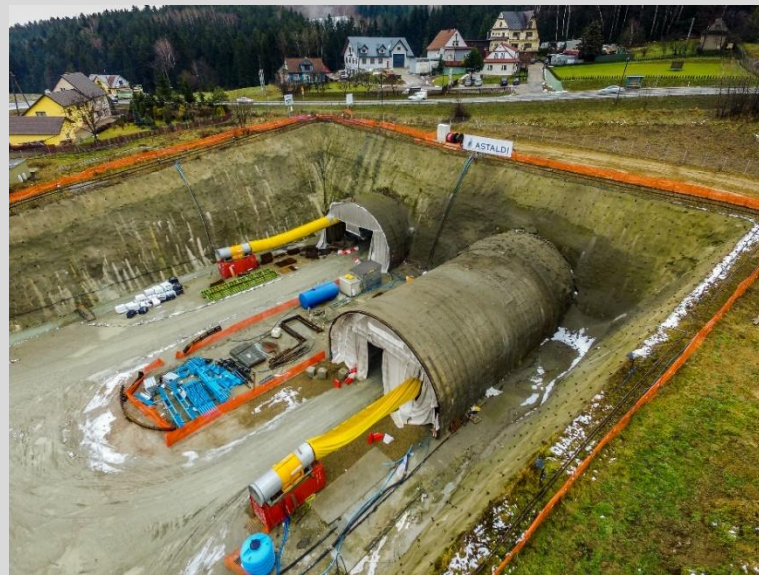
Tunel od strony północnej
