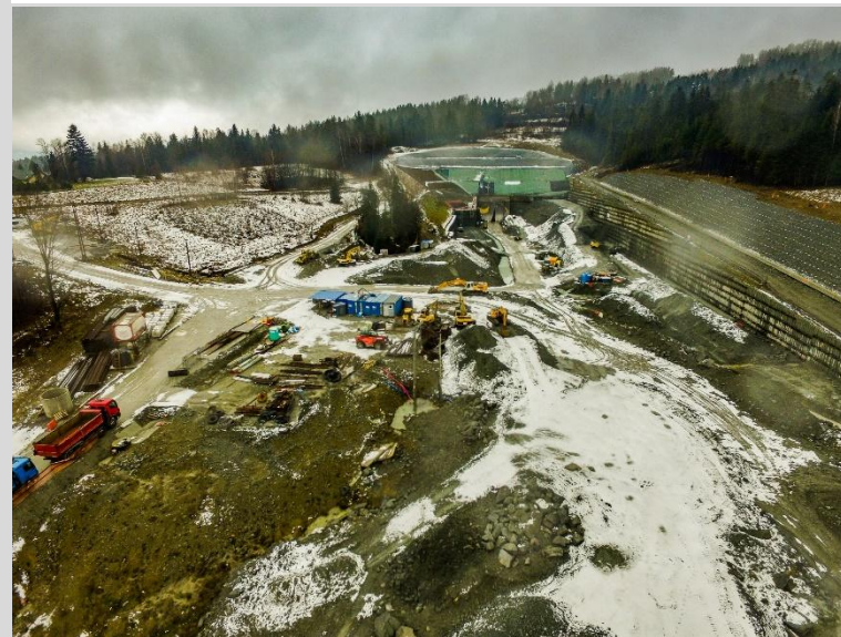
Tunel od strony południowej
