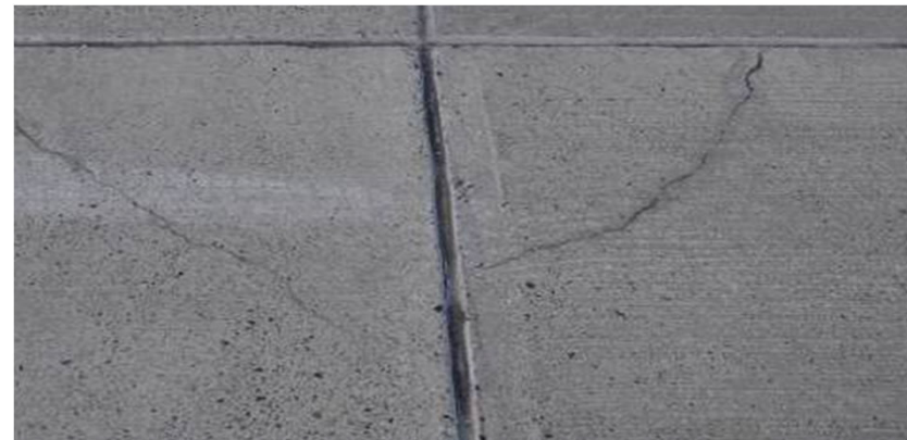
USZKODZENIA KRAWĘDZI I NAROŻNIKÓW
