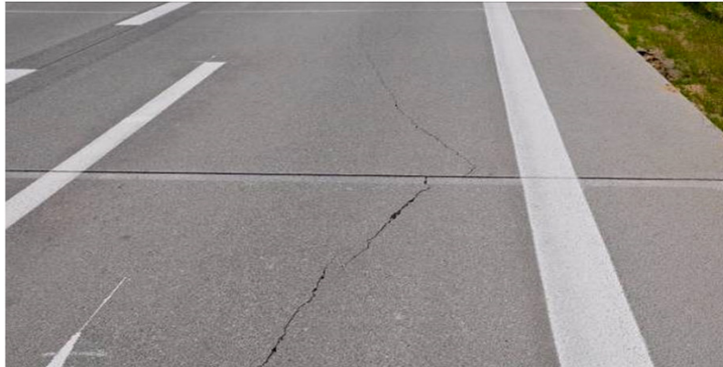
PEKNIĘCIA PŁYT WSKUTEK ZANIECZYSZCZEŃ SZCZELIN
