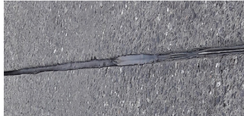
NIEWŁAŚCIWE WYPEŁNIENIE MASAMI ZALEWOWYMI
