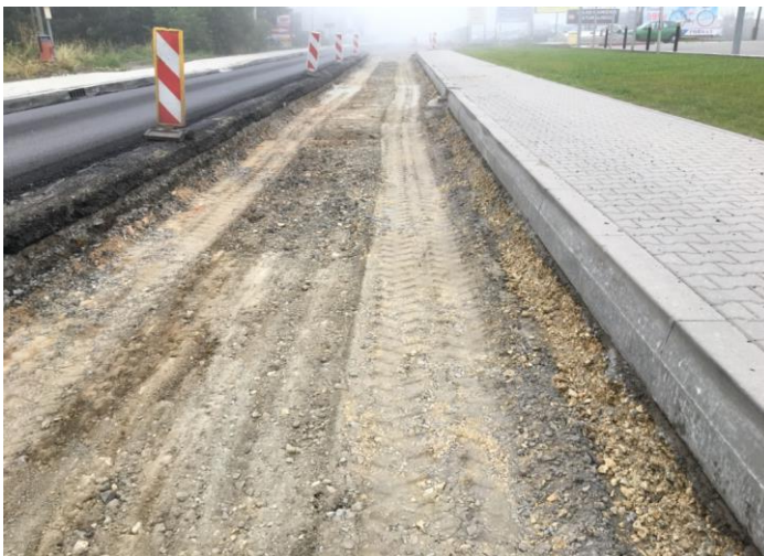
Koryto jezdni drogi wojewódzkiej w stanie suchym
