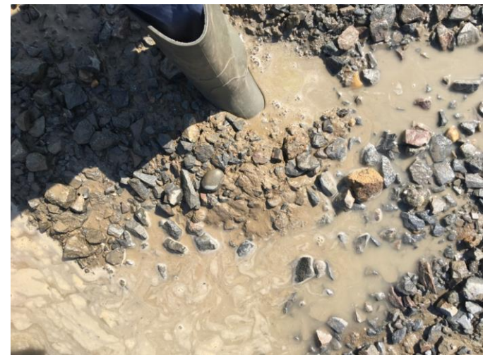
Koryto jezdni drogi wojewódzkiej po intensywnych opadach
