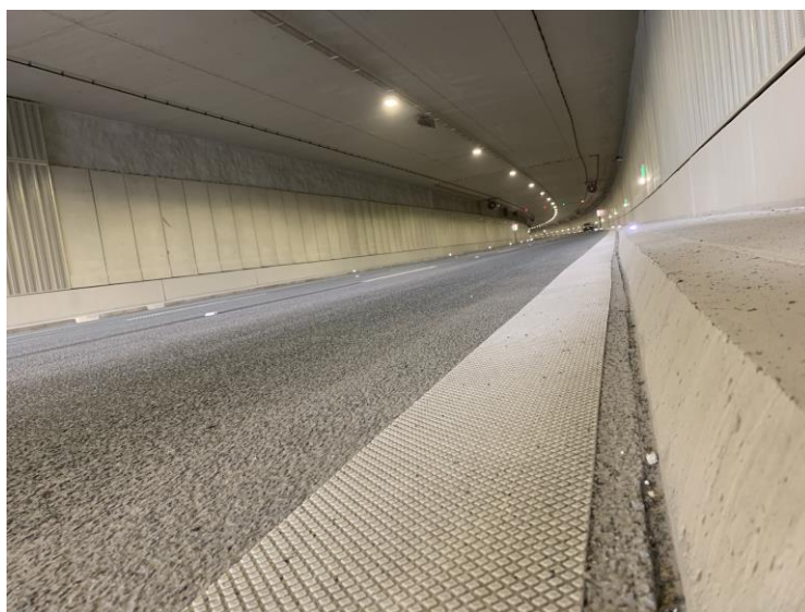
Taśma 3M™ STAMARK™ A380iES w tunelu drogi S2 w Warszawie, GDDKiA
