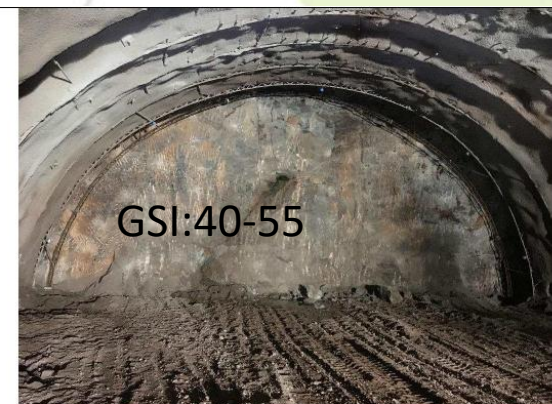
Rysunek 1. Fig. 1: Overview tunnel face. Alternating layers of conglomerate, sandstone and mudstone. Rock mass faulted and fractured. Ground types predominantly C2, subordinate C3. / Przegląd czola przodka. Naprężenie warstwy zlepieńca, piaskowca i mulowca. Górotwór zaburzony i spękany. Przeważa typ gruntu C2, podrzędnie C3.
