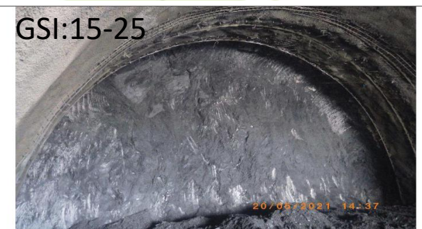
Rysunek 1. Fig. 1: overview face, serizitic and graphitic schists. Ground type O2 and O3. / Przegląd czola przodka, lupek serycytowy i grafitowy. Klasa górotworu O2 / O3.
