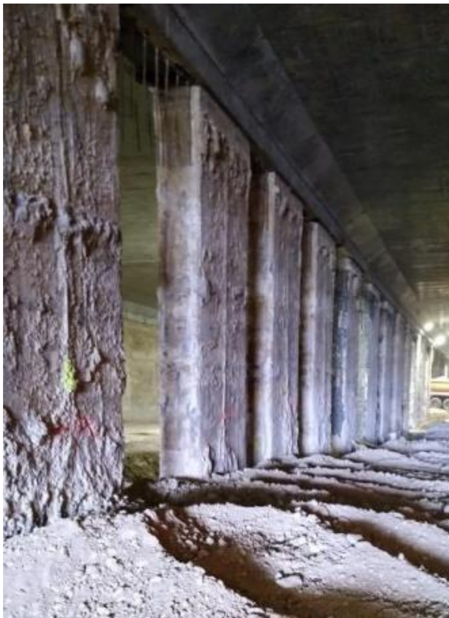
-Przywrócenie nośności podpory środkowej – BARTEY
