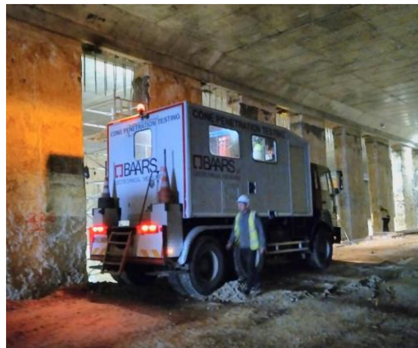
-Weryfikacja przyczyn , szczegółowe rozpoznanie geotechniczne
