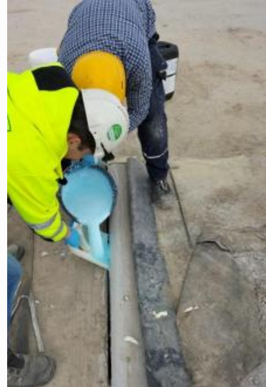
-Naprawa uszczelnień
