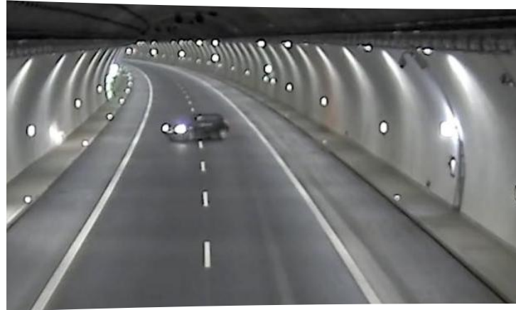
Jazd pod prąd, a także szybkie wykrycie zagrożenia pożarowego
