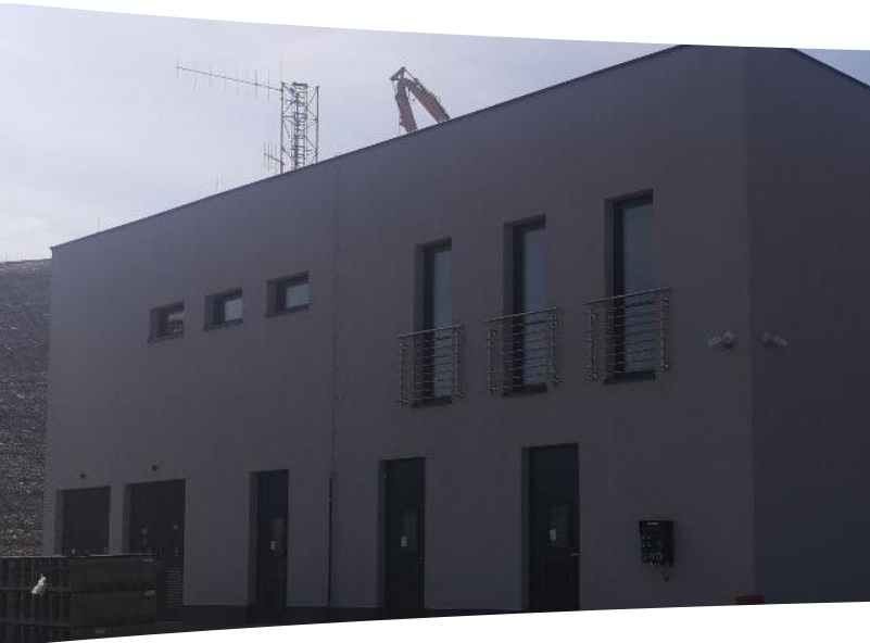
Budynek Dyspozytorni Rezerwowej Budynek Techniczny
