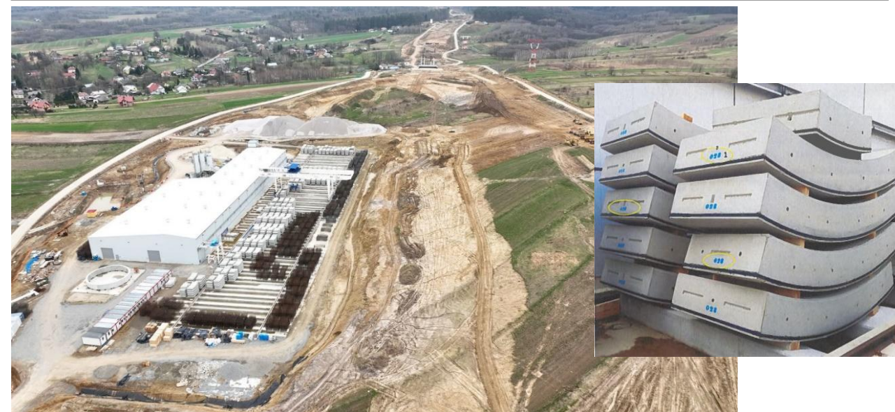
Zakład prefabrykacji na MOP Lutoryż
