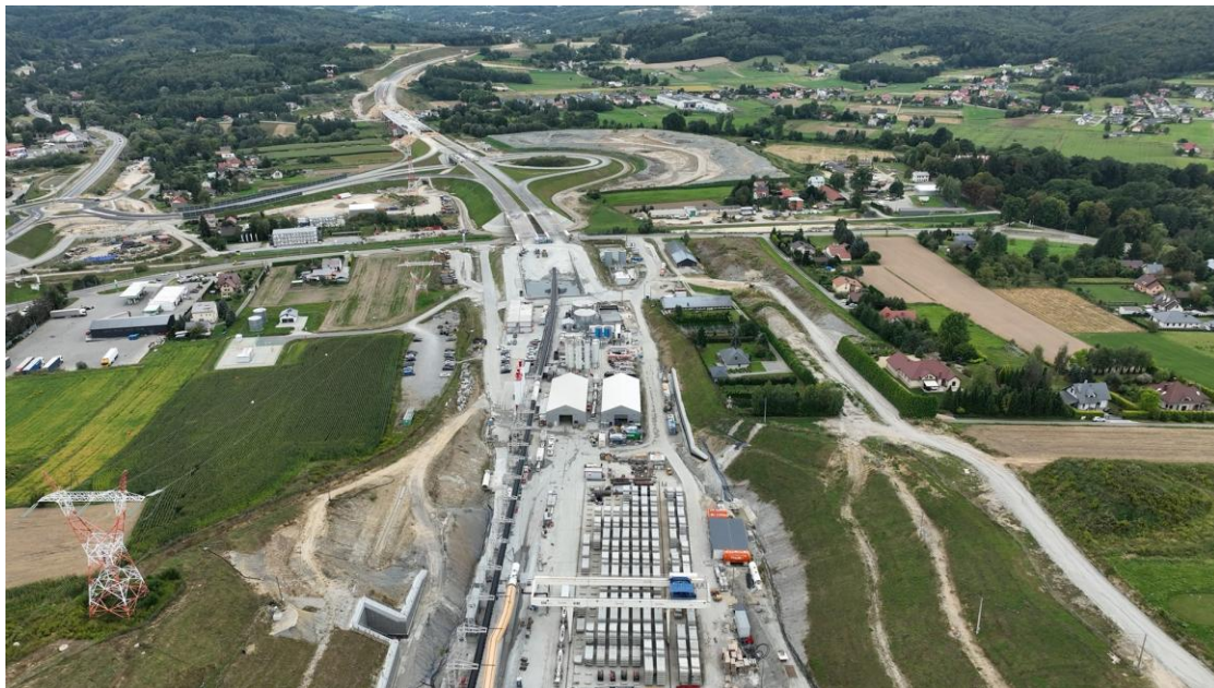
Portal południowy zaplecze budowy tunelu z widokiem na w. Babica
