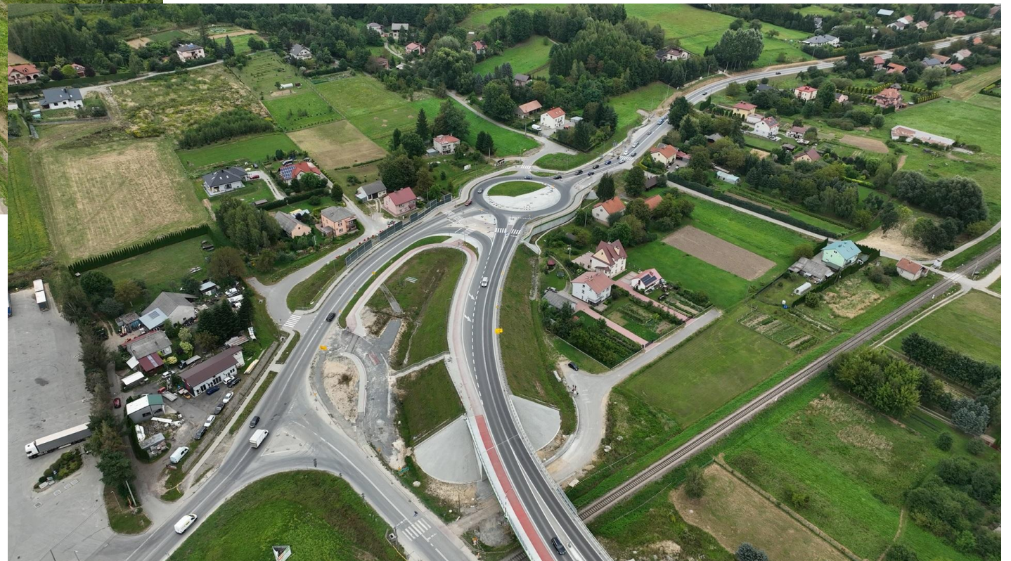
Przebudowa DK19 z wiaduktem na linią kolejową
