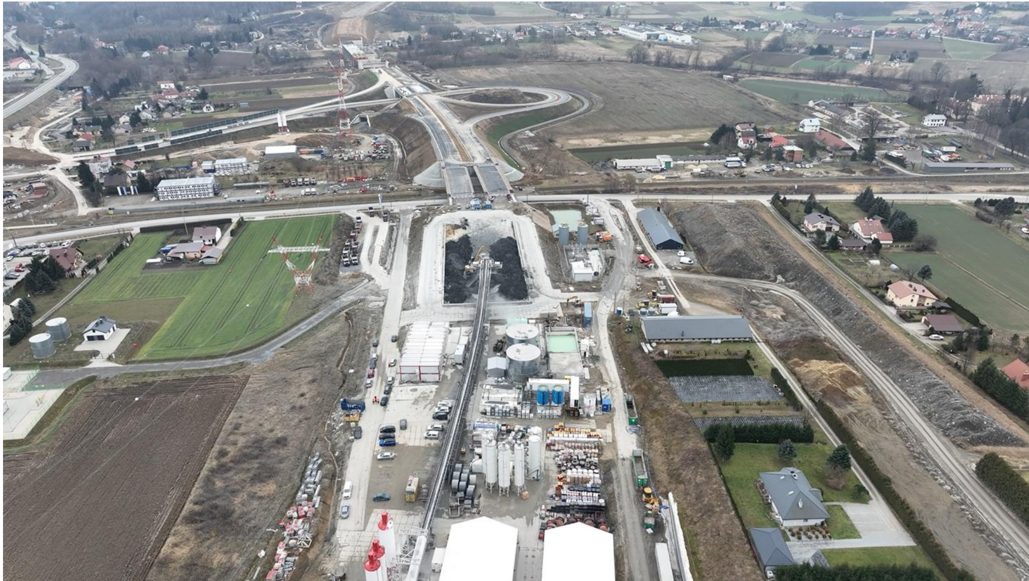
Portal południowy tunelu – taśmociąg i zbiornik na urobek Muck Pit
