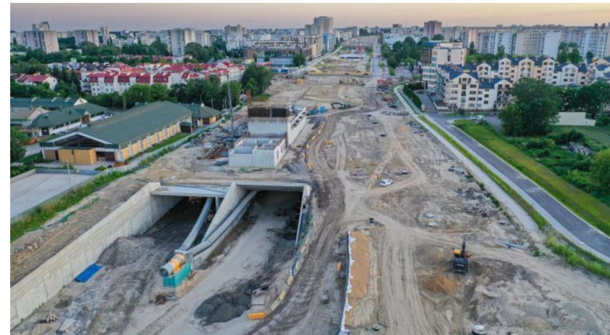
Metoda odkrywkowa – ścian szczelinowych
