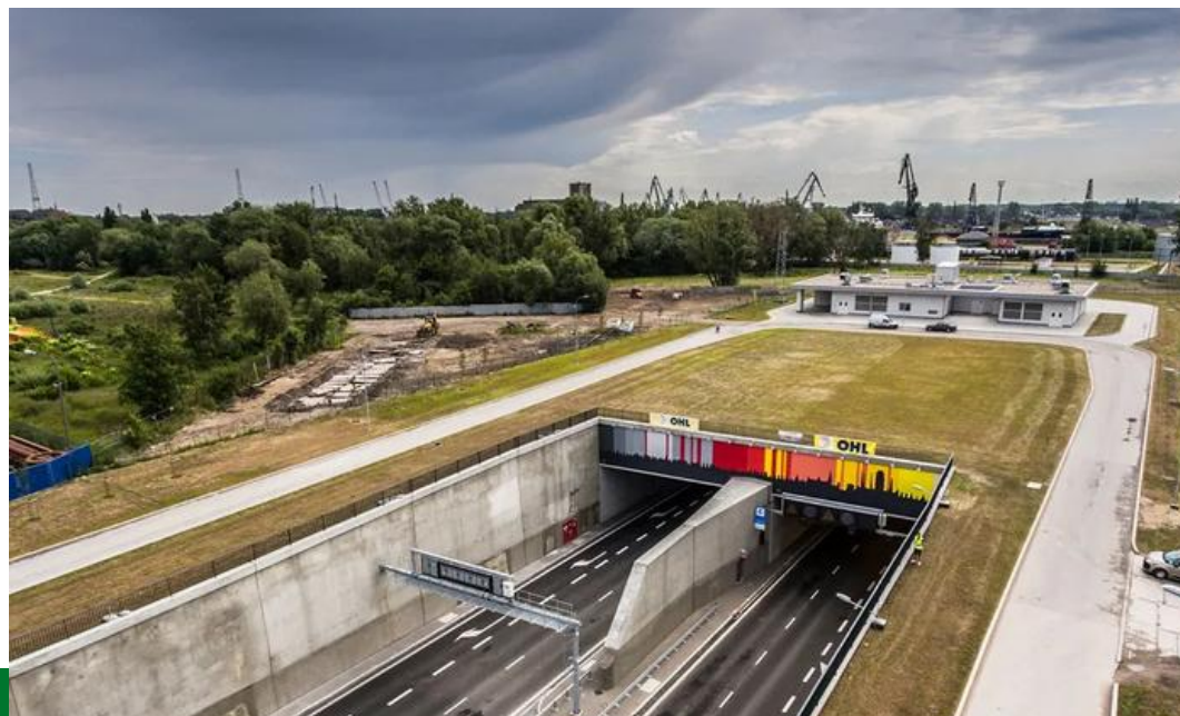
Tunel pod Martwą Wisłą
