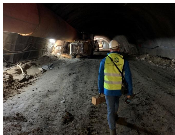
Rysunek 1.4 Pomiary wentylacyjne w drażonych tunelach drogowych w Węgierskiej Górcie (anemometr Benetech GT8907 oraz \mu As4, mierniki gazów MX6, barometr elektroniczny \mu Bar, psychrometr Assmanna). Źródło: Mirbud, opracowanie własne.
