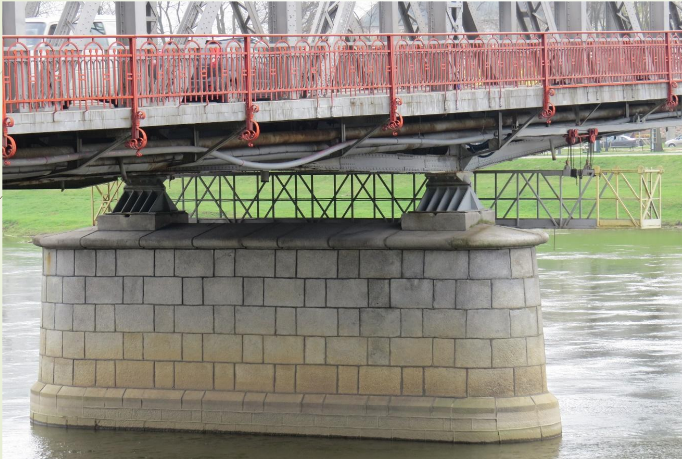
Podpora z łożyskami, wózek inspekcyjny, rok 2017
