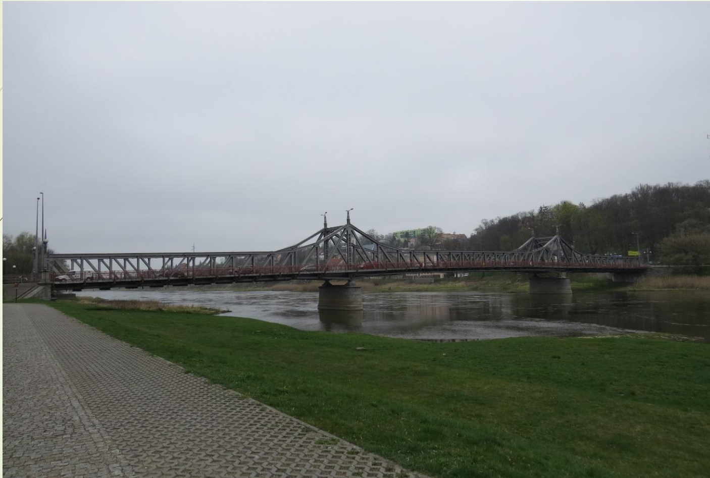
Widok mostu od strony wschodniej, rok 2017
