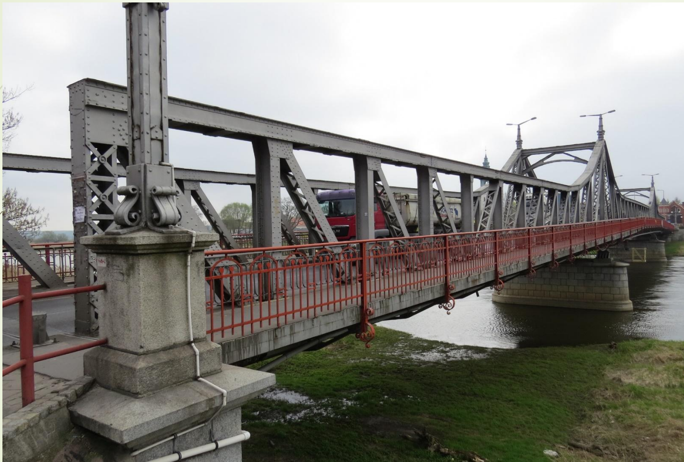
Kratownica od strony zachodniej, rok 2017
