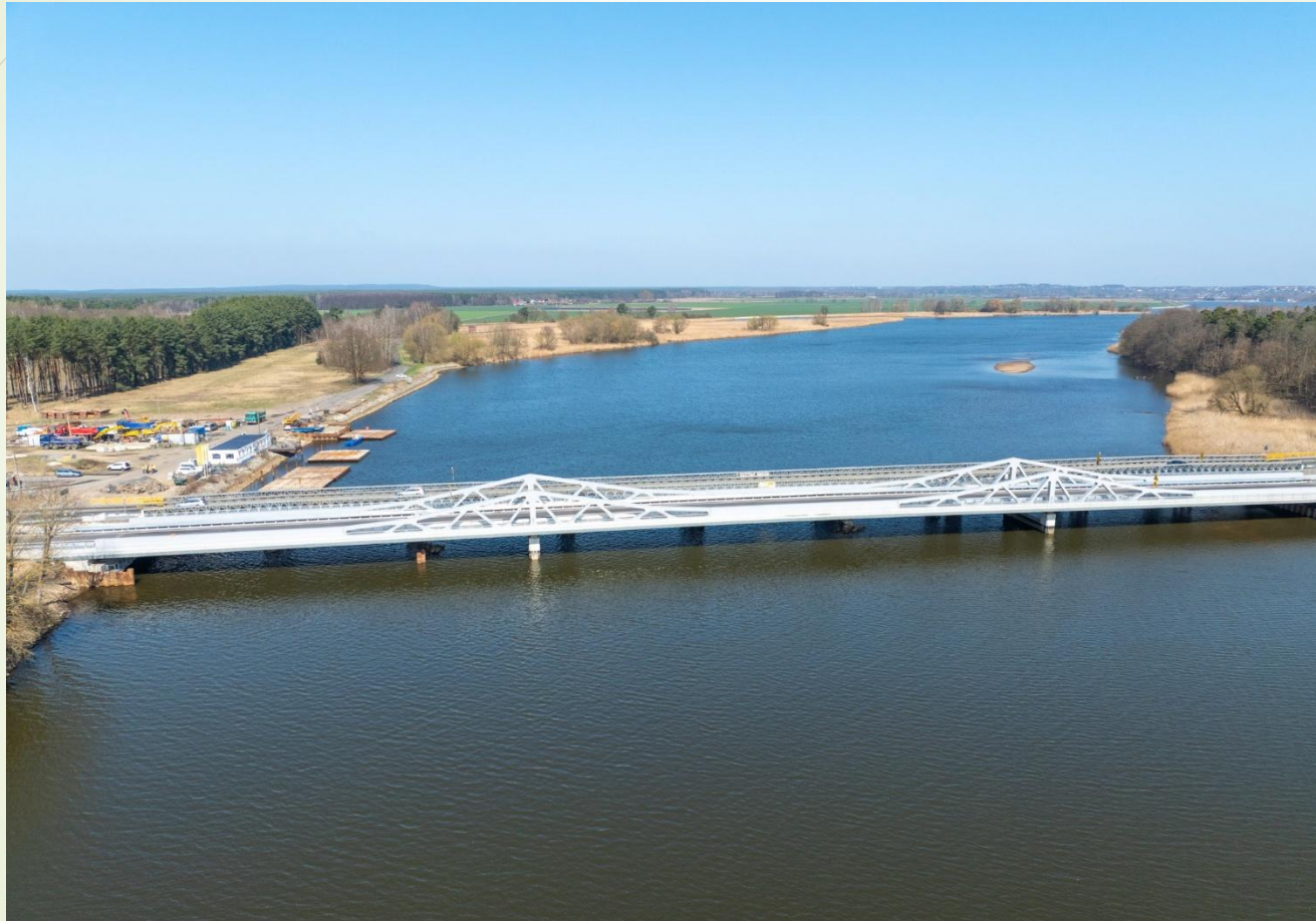
Most od strony południowej (GDDKiA, M. Pilaczyński)
