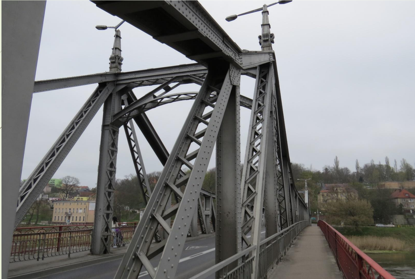
Kratownica nad podporą, rok 2017
