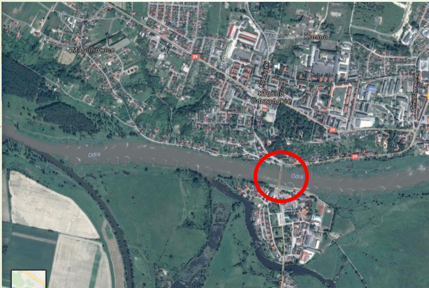
Lokalizacja mostu (Google Maps)
