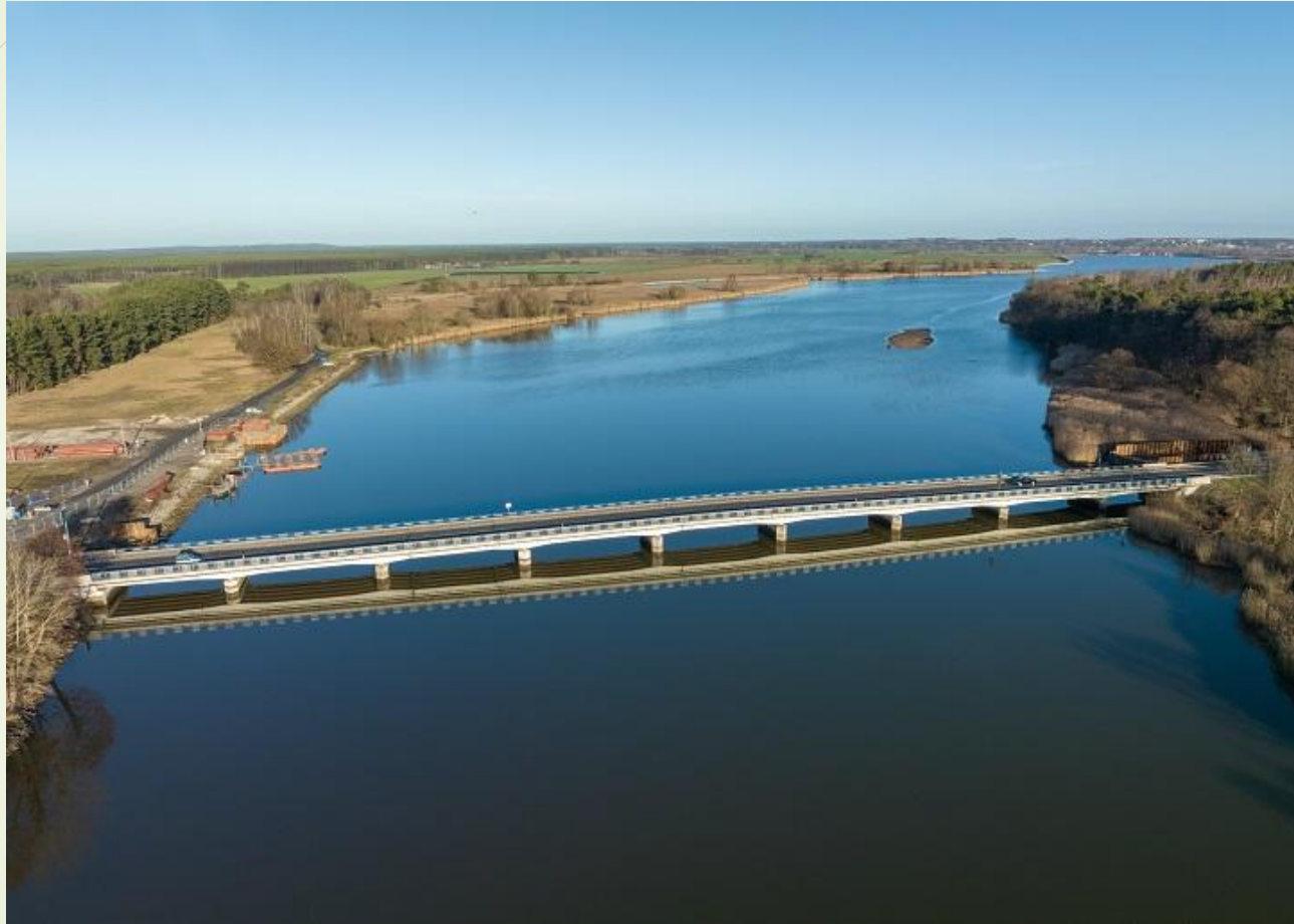
Most od strony południowej (GDDKiA, M. Pilaczyński)
