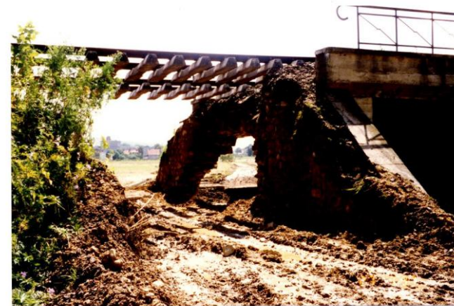
Fot. 10. Widok rozmytego nasypu za przyczółkiem wiaduktu kolejowego nad drogą polną na trasie Kłodzko - Międzygórze linii Wrocław - Międzyzlesie, 27.07.1997 r.
