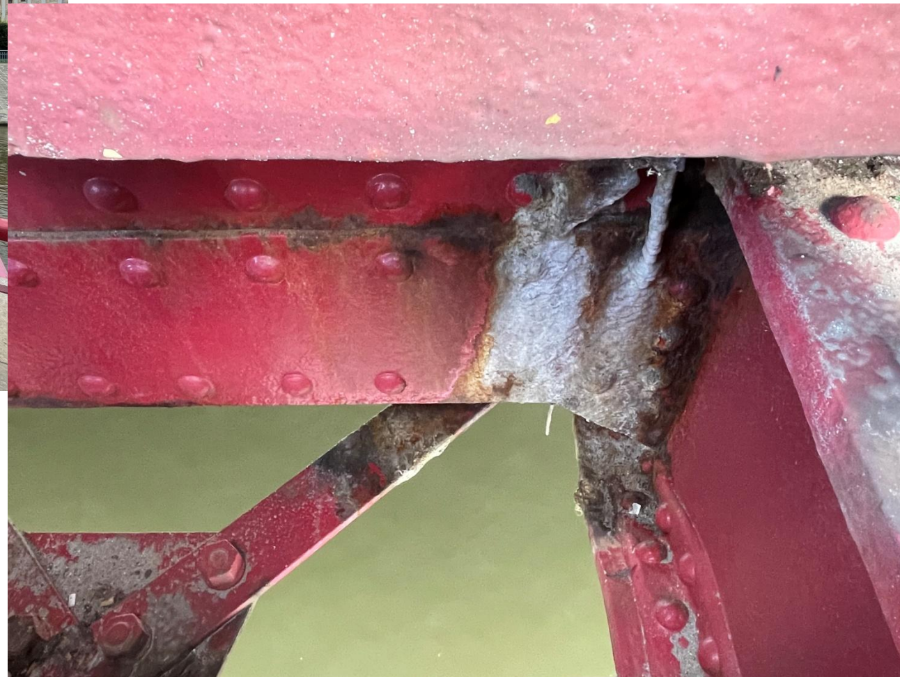
MOST PIASKOWY WE WROCŁAWIU STAN ZABEZPIECZEŃ ANTYKOROZYJNYCH PO REMONCIE
