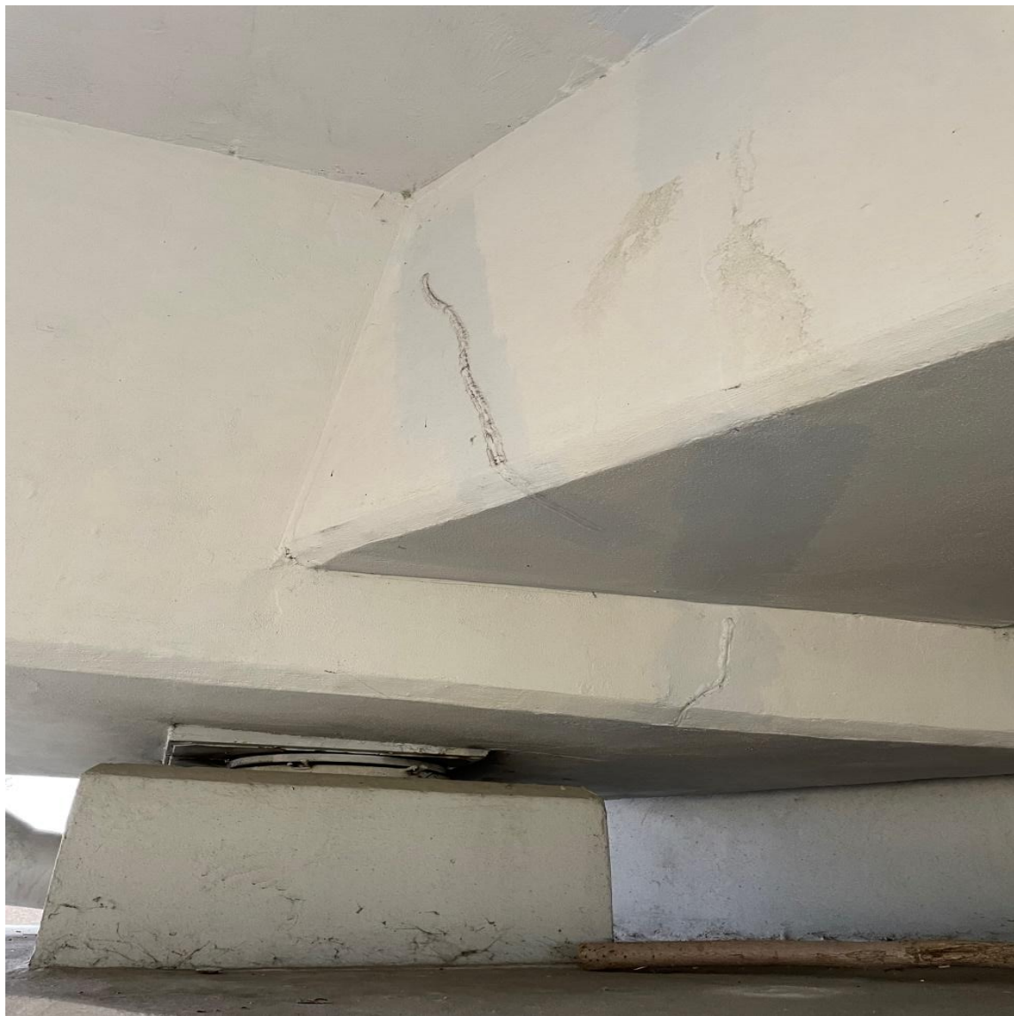
RYSY POPRZECZNIC PODPOROWYCH
