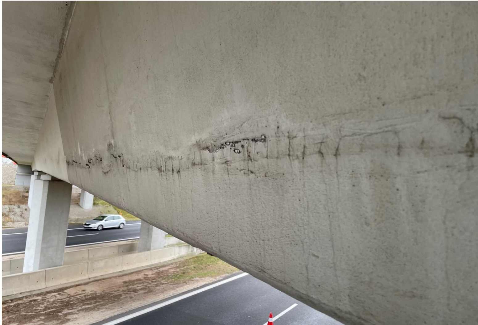
RYSA DŹWIGARA KABLOBETONOWEGO
