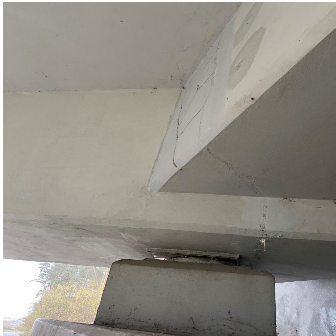
RYSY POPRZECZNIC PODPOROWYCH
