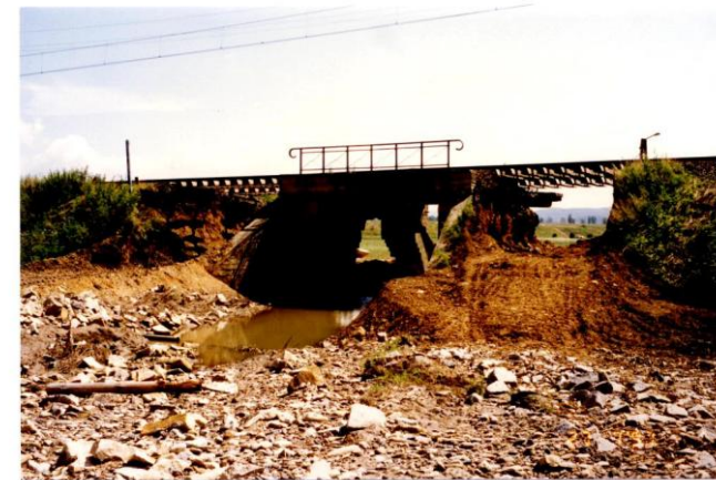
Fot. 11. Widok rozmytego nasypu za przyczółkiem wiaduktu kolejowego nad drogą polną na trasie Kłodzko - Międzygórze linii Wrocław - Międzyzlesie, 27.07.1997 r.
