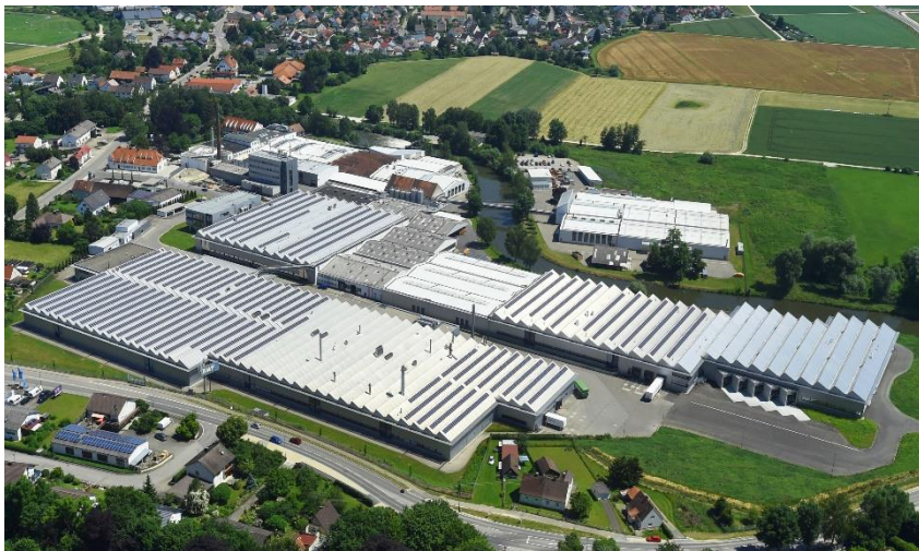
BWF Envirotec: Główna siedziba Offingen/Bavaria
