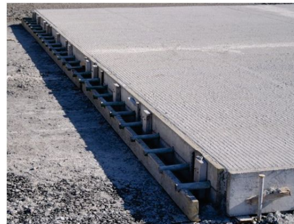
Proste rozwiązanie poziomowania dybli w dylatacjach roboczych na zakończeniu działki (dziejnej) USA 2018
