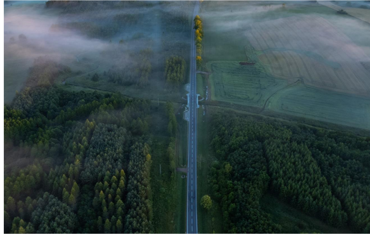
Rozbudowa drogi wojewódzkiej nr 512 na odcinku Pieniężno – Bartoszyce
