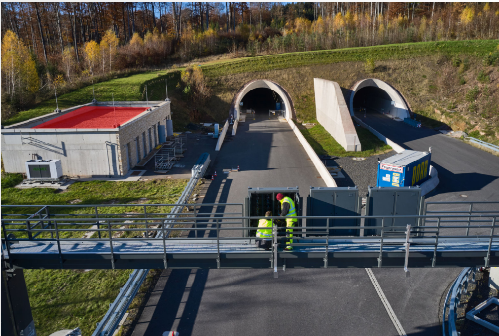
Ostportal und Betriebsgebäude Ost
