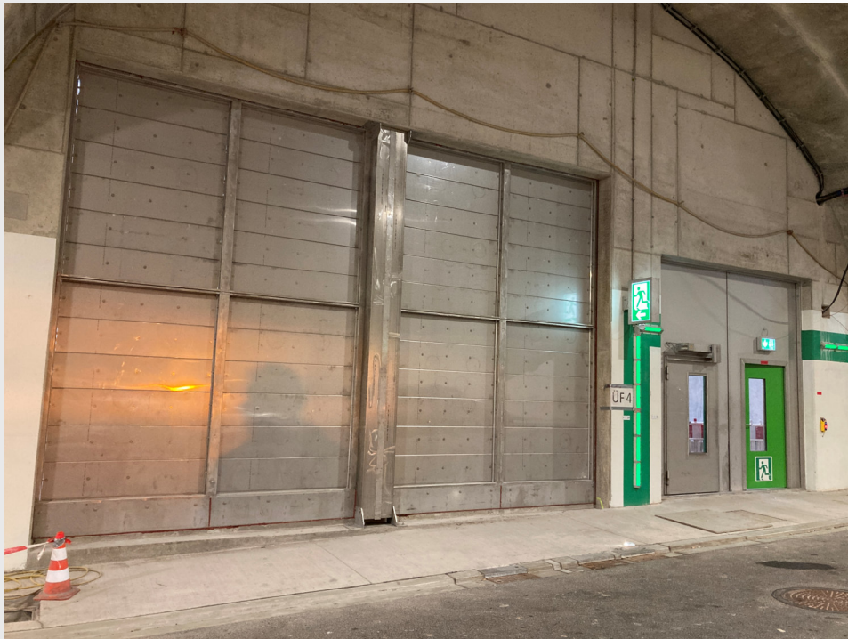
Lüftungsklappen Mittenabsaugung
