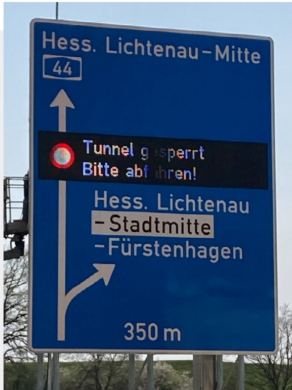
Dynamischer Wegweiser an der BAB 44
