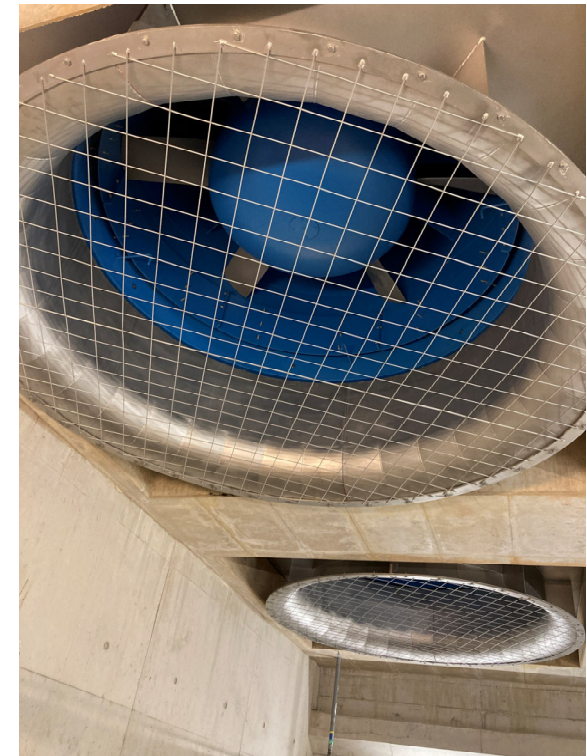
240 kW Axialventilatoren (d ~ 3m)
