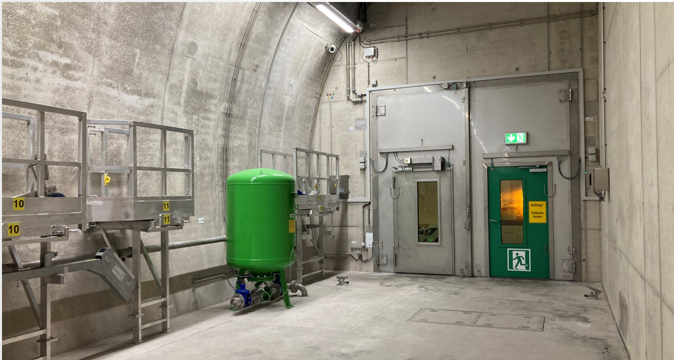
Membranausdehnungsgefäße in den Querschlägen
