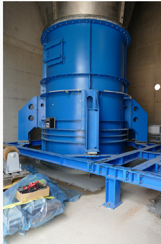
240 kW Axialventilatoren (d ~ 3m)
