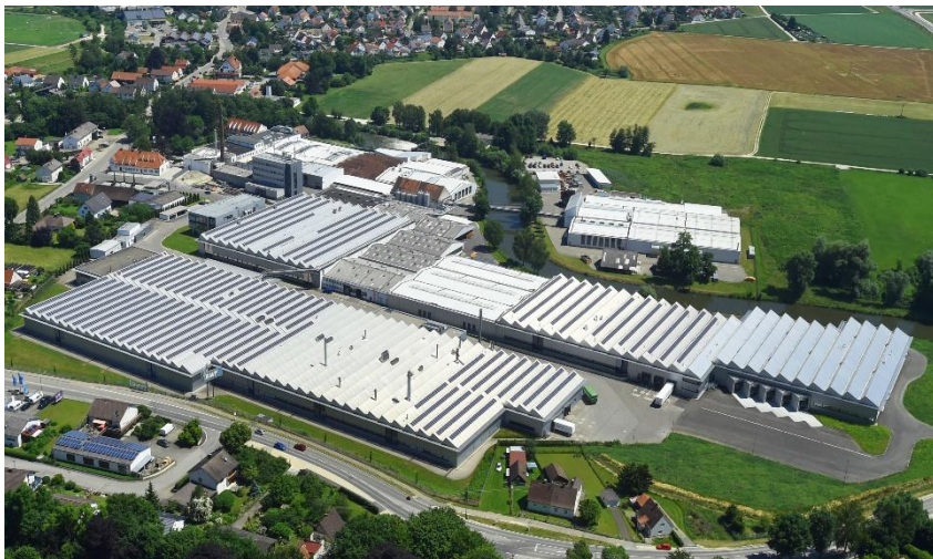
BWF Envirotec: Główna siedziba Offingen/Bavaria
