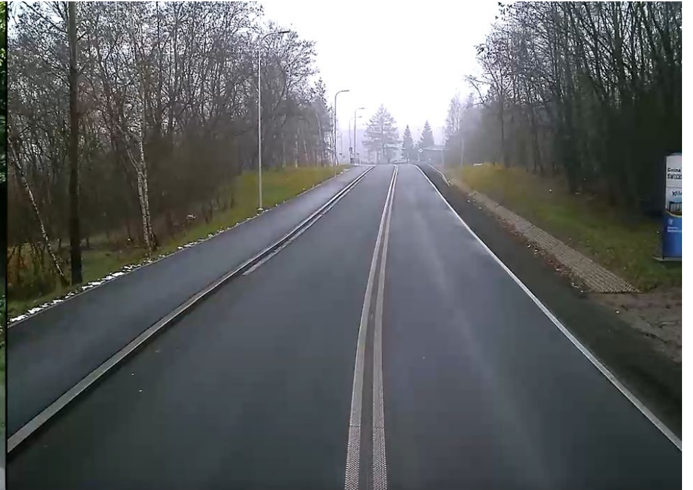
Po zakończeniu przebudowy
