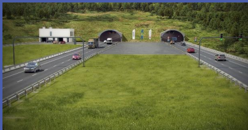
Droga ekspresowa S3 - zadanie 3 PORR S.A.
