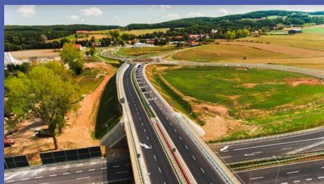
Droga ekspresowa S3 - zadanie 2 Mota-Engil Central Europe S.A.
