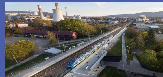
Rekonstrukcja linii kolejowej nr 139 Intop Warszawa Sp. z o.o.
