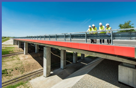
Obwodnica Nysy Mota-Engil Central Europe S.A.
