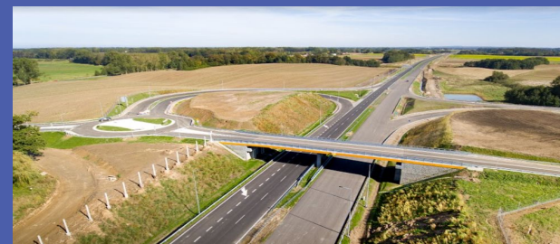
Droga ekspresowa S6 Strabag Infrastruktura Południe Sp. z o.o.
