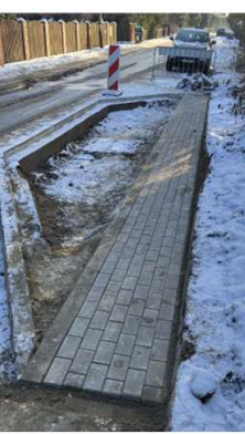
Wypustki uliczne Budowa ul. Żuławska – budowa i zdjęcia poglądowe (Detroit)
