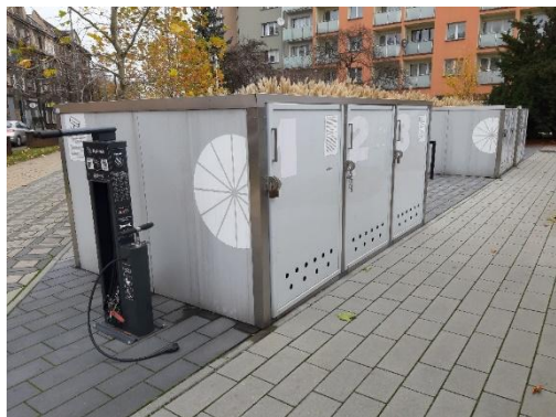
Boksy rowerowe przy dworcu kolejowym w Rybniku źródło: Michał Kwiatkowski
