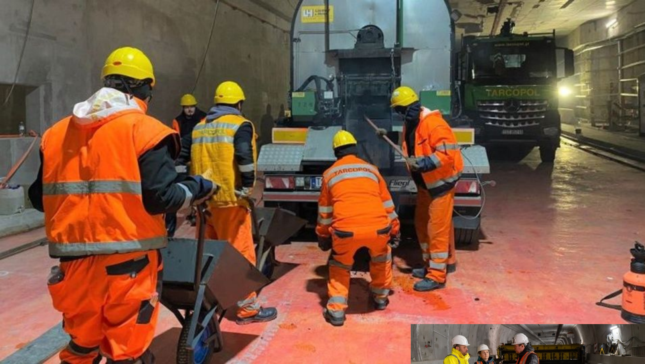
Układanie asfaltu w tunelu w Świnoujściu Miejsce słabo wentylowane, duże narażenie oddechowe
