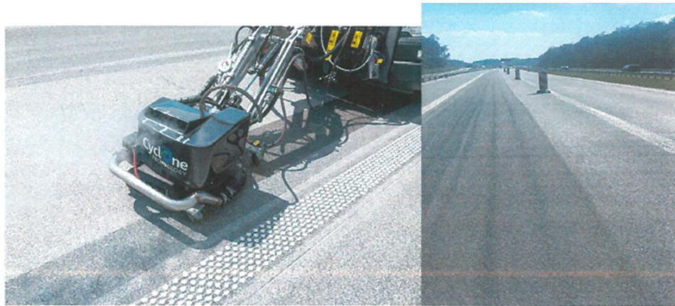
Uszorstnienie nawierzchni SMA LA na inwestycji S6
