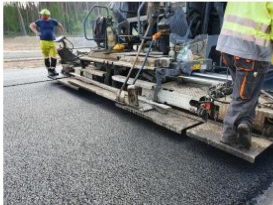
Fot. 3. Układanie mieszanki SMA 11
