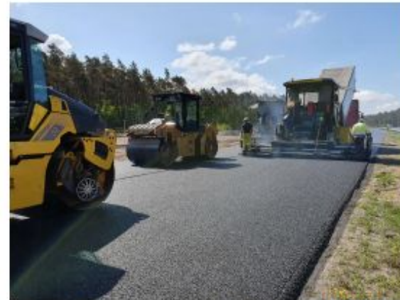
Fot. 4. Zagęszczanie mieszanki SMA 11
