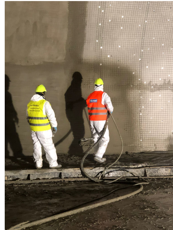
Zabezpieczenie natryskiem ogniochronnym Fendolite MII
