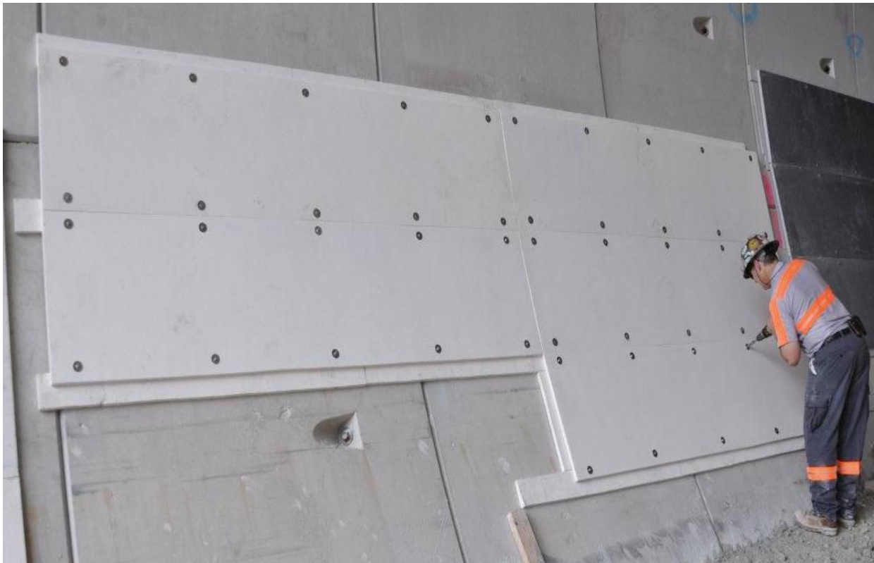
Zabezpieczenie płytami ogniochronnymi PROMATECT
