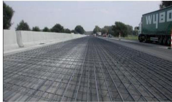
Ciągłe zbrojenie betonu cementowego
