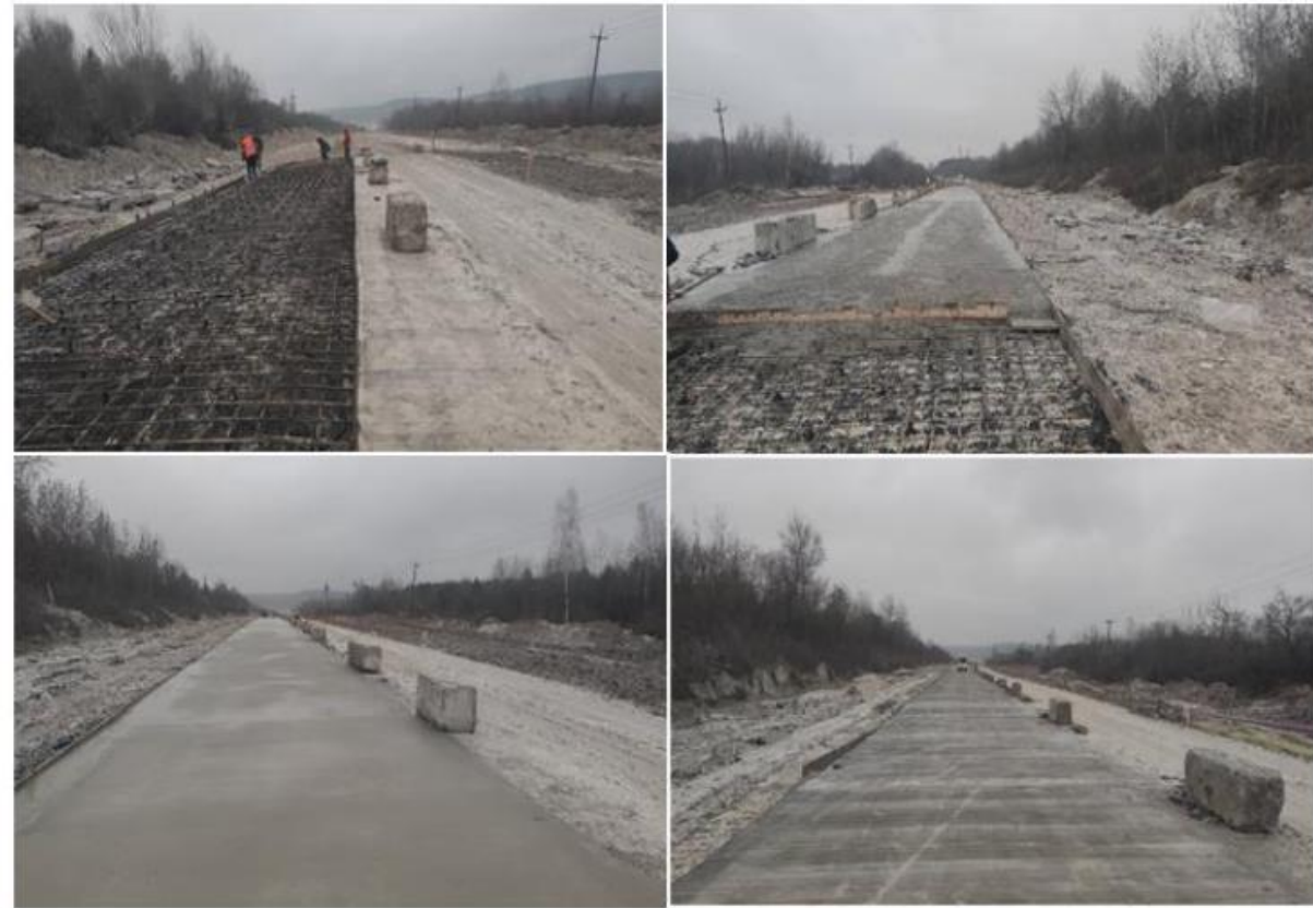
Drogi betonowe oddziału Wołyń Cement
