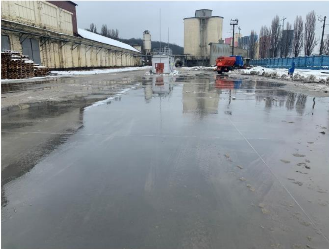
Betonowa droga terminalu w Kijowie
