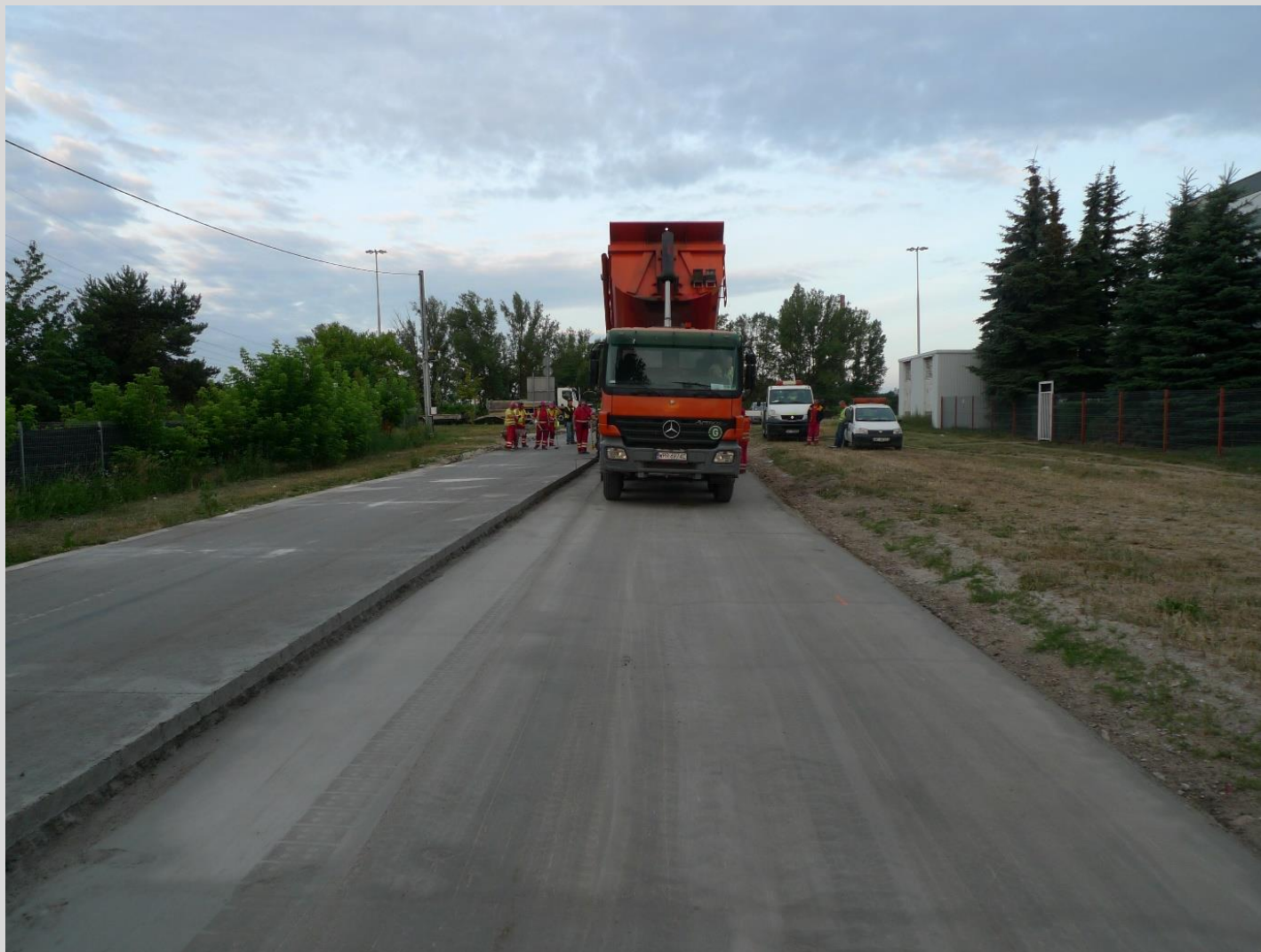
Fot. 7 Podłużna szczelina konstrukcyjna w nawierzchni drogi z betonu wałowanego o szerokości powyżej 6 m
