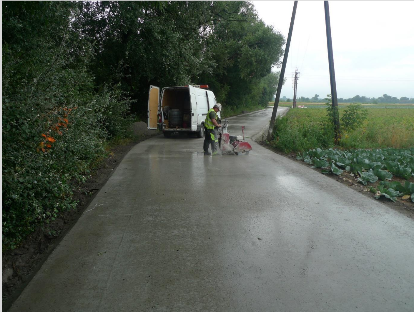
Fot. 6 Wykonanie poprzecznych szczelin pozornych w nawierzchni z betonu wałowanego
