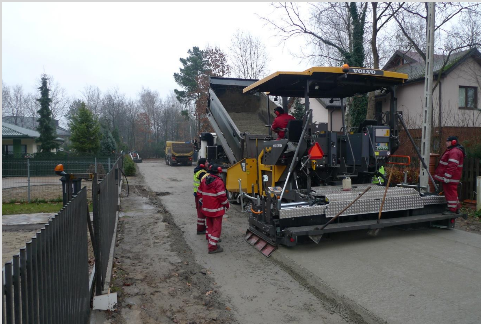
Fot. 3 Rozładunek i układanie mieszanki z betonu wałowanego
