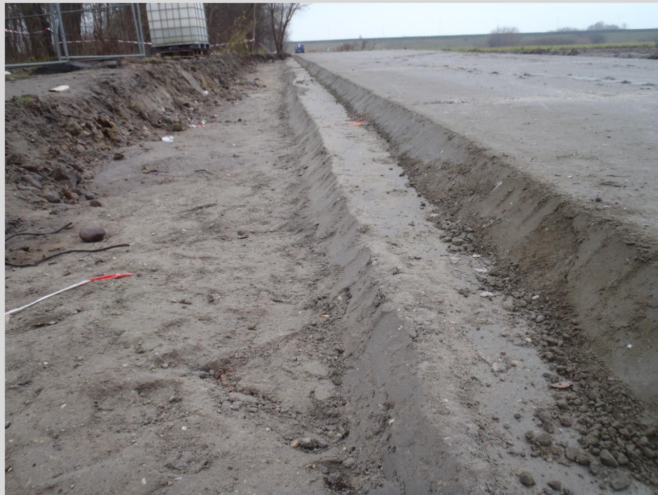
Fot. 2 Nawierzchnia z betonu wałowanego składa się z następujących warstw: beton nawierzchniowy (RCC) gr. 18 cm, podbudowa z gruntu stabilizowanego cementem R_m 2,5 – 5,0 MPa, podłoże gruntowe doprowadzone do nośności G1
