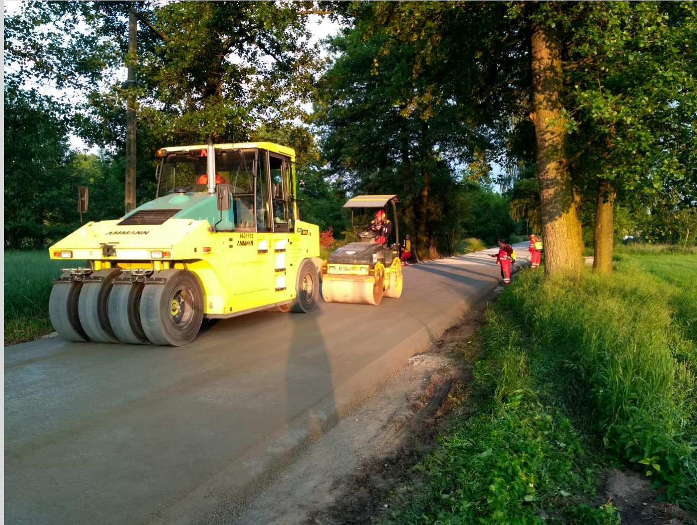
Fot. 4 Zestaw walców podczas zagęszczania nawierzchni z betonu wałowanego
