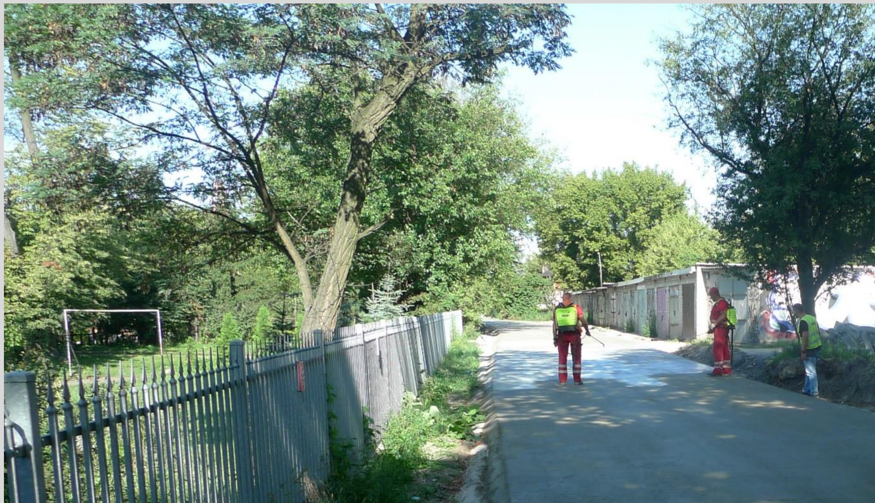
Fot. 5 Natrysk preparatu do pielęgnacji świeżej mieszanki betonowej
