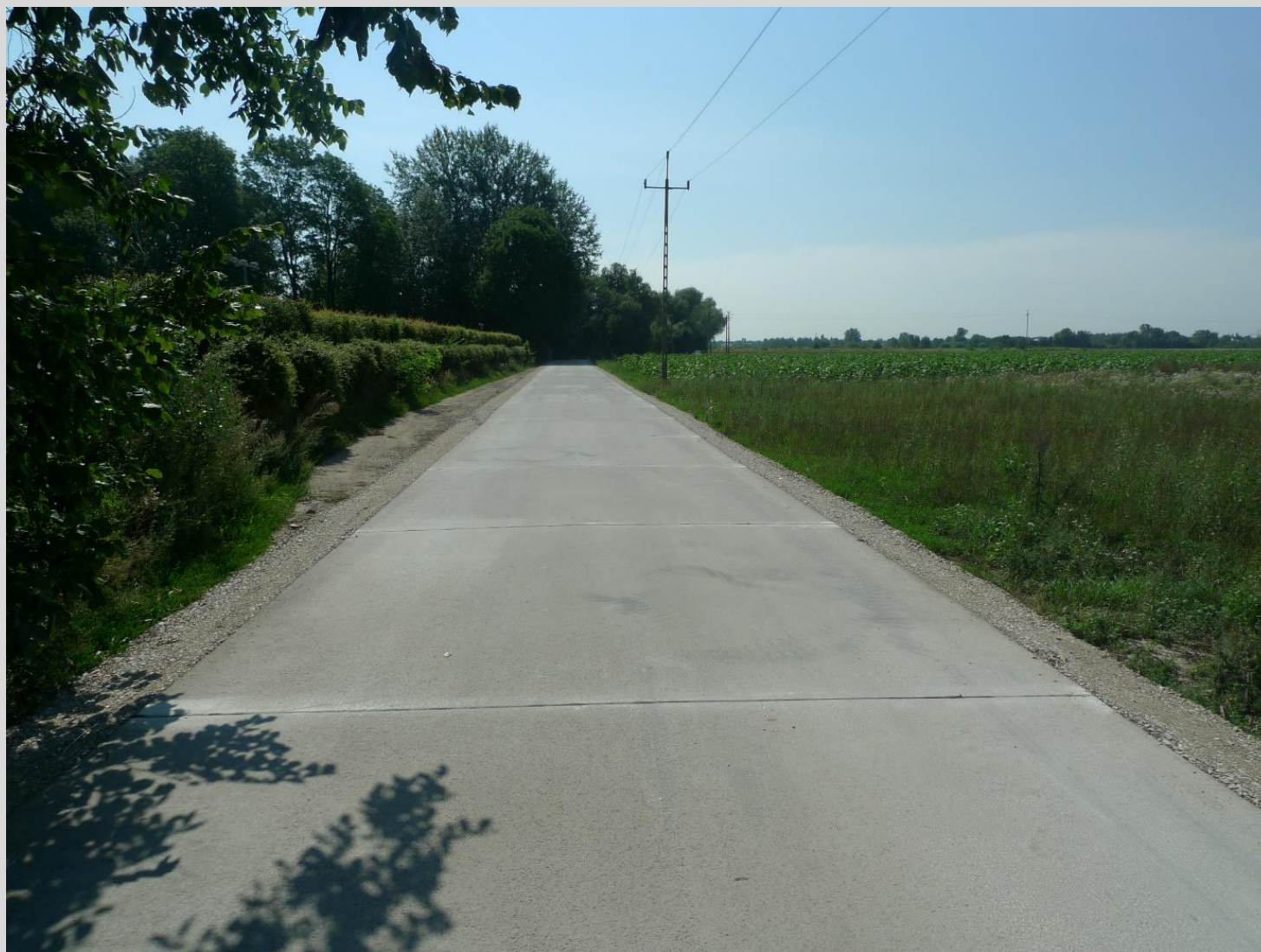
Fot. 1 Jezdnia z betonu wałowanego
