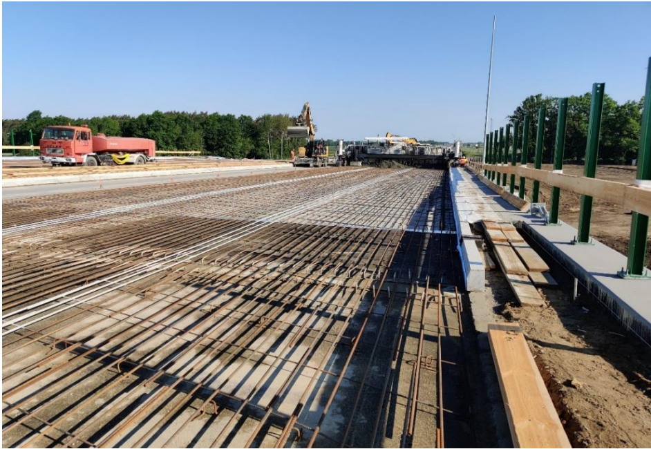
Wykonanie nawierzchni betonowej o zbrojeniu ciągłym - most nad Raciążnicą
