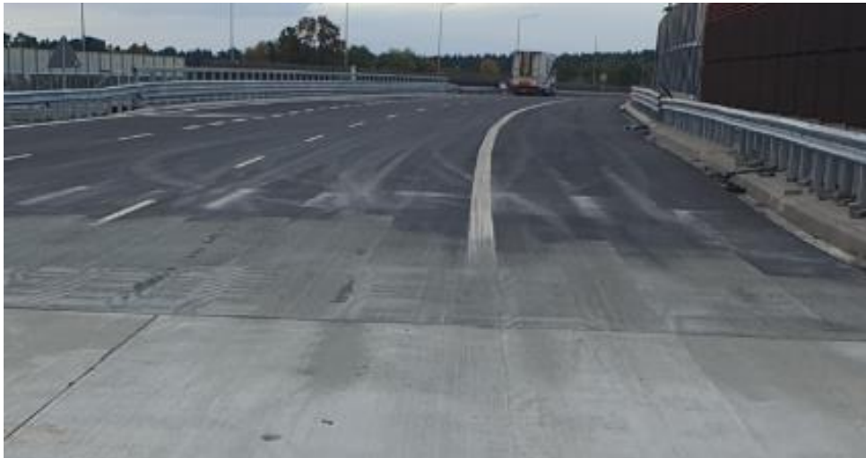
Szlifowanie nawierzchni na styku nawierzchni bitumicznej i betonowej (na etapie budowy)
