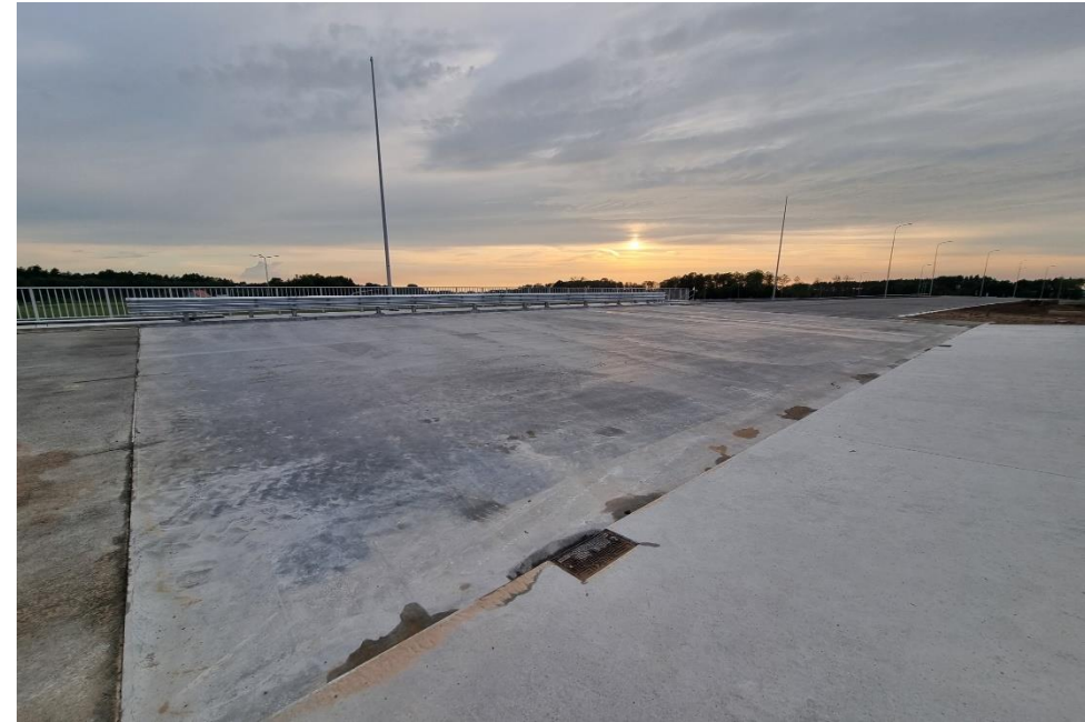
Wykończenie nawierzchni betonowej na płycie pomostu (jazda po uszorstnionej płycie pomostu)
