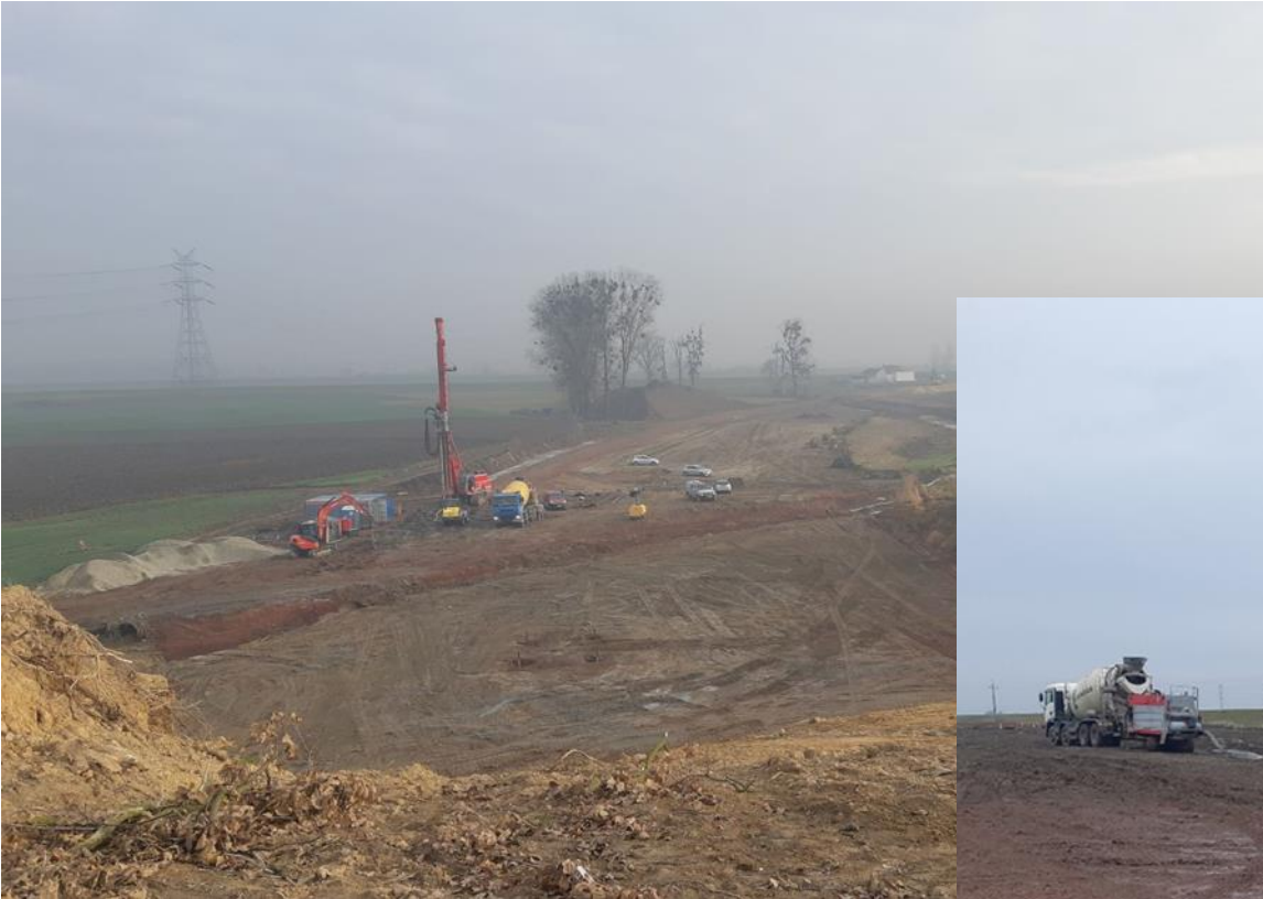
Wykonywanie wzmocnienia podłoża za pomocą kolumn przemieszczeniowych w km 3+220.
