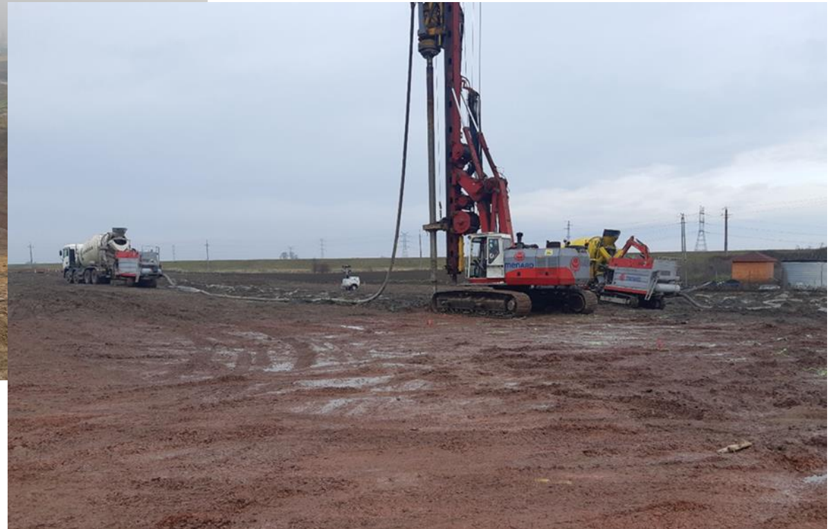
Wykonywanie wzmocnienia podłoża za pomocą kolumn przemieszczeniowych w km 6+600.
