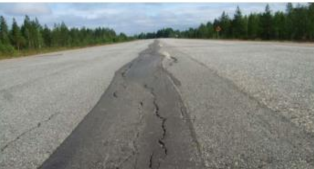
Spękania temperaturowe
