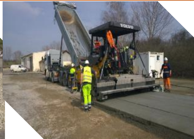
Zapewnienie stałego dowozu mieszanki do rozścielacza asfaltowego
