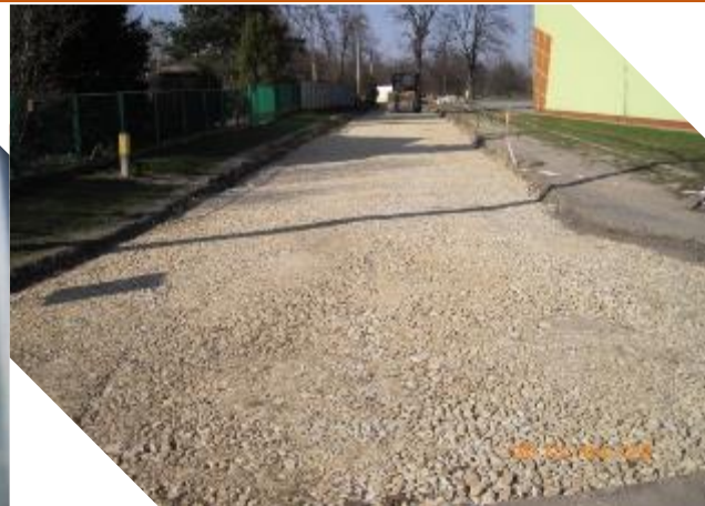
Przygotowanie podłoża pod nawierzchnię
