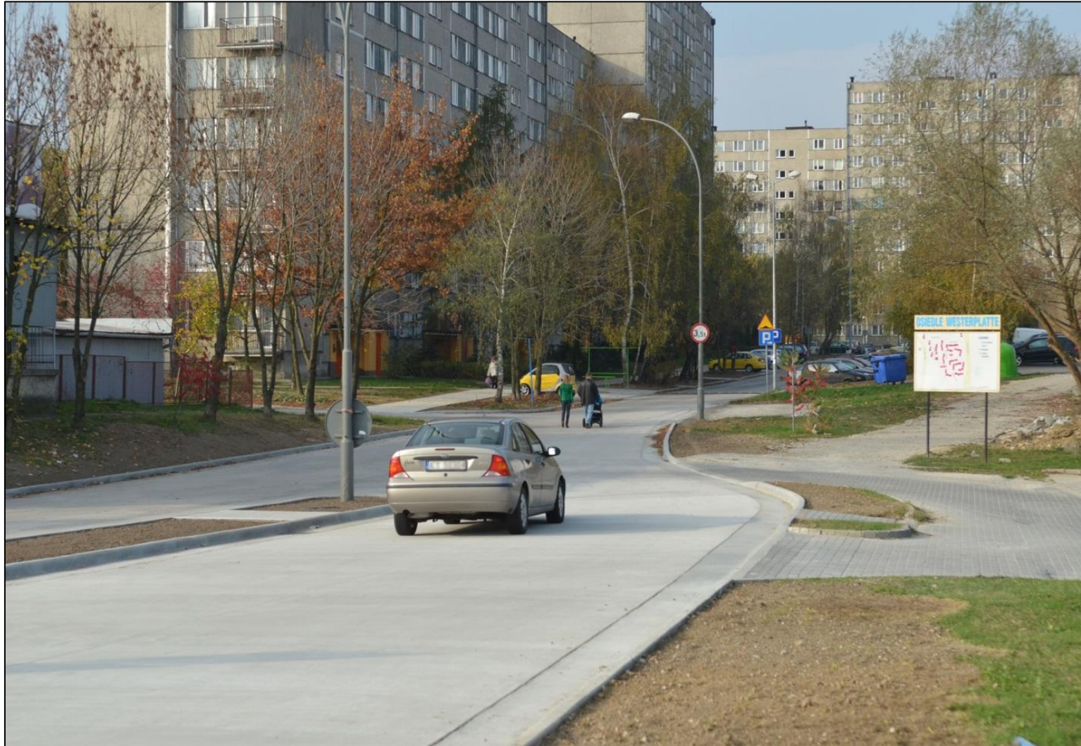
Nawierzchnia betonowa – Tarnów, ul.Westerplatte
