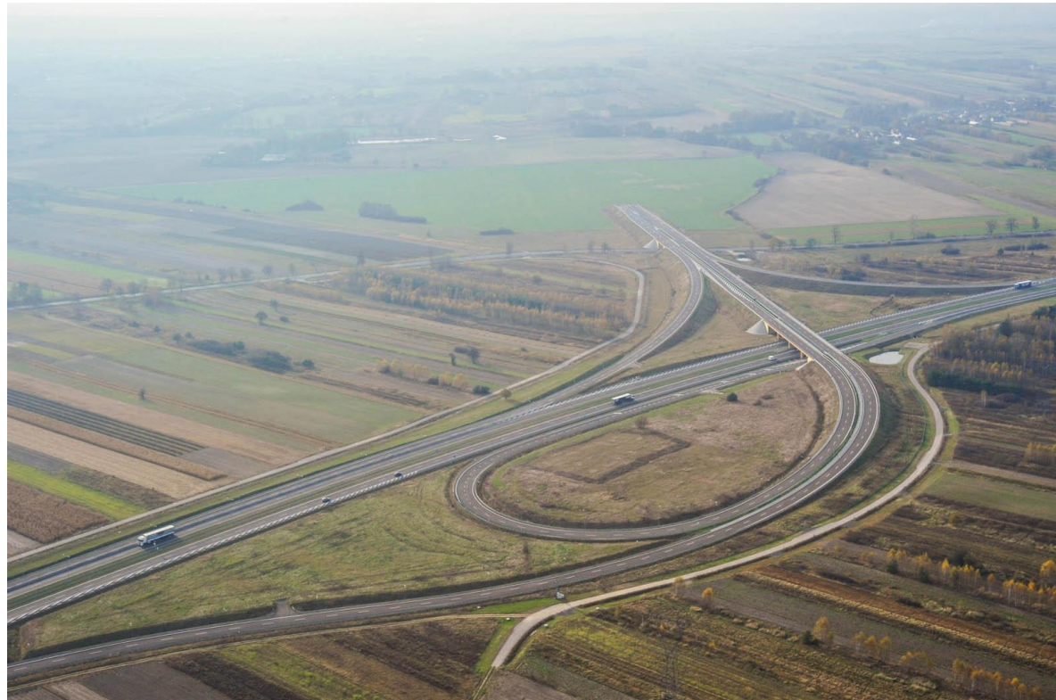
Węzeł „Kurów Zachód” – włączenie realizowanego odcinka na skrzyżowaniu dróg ekspresowych S12 i S17
