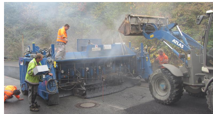
układanie asfaltu lanego
