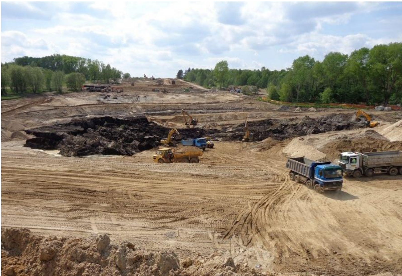
Budowa S7, odc. B/ DK16 – wymiana gruntu, węzeł „Harfa”.
