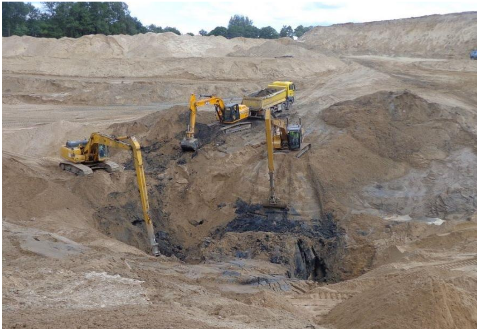
Budowa S7, odc. B/DK16 - głęboka wymiana, okolice węzła „Harfa”.
