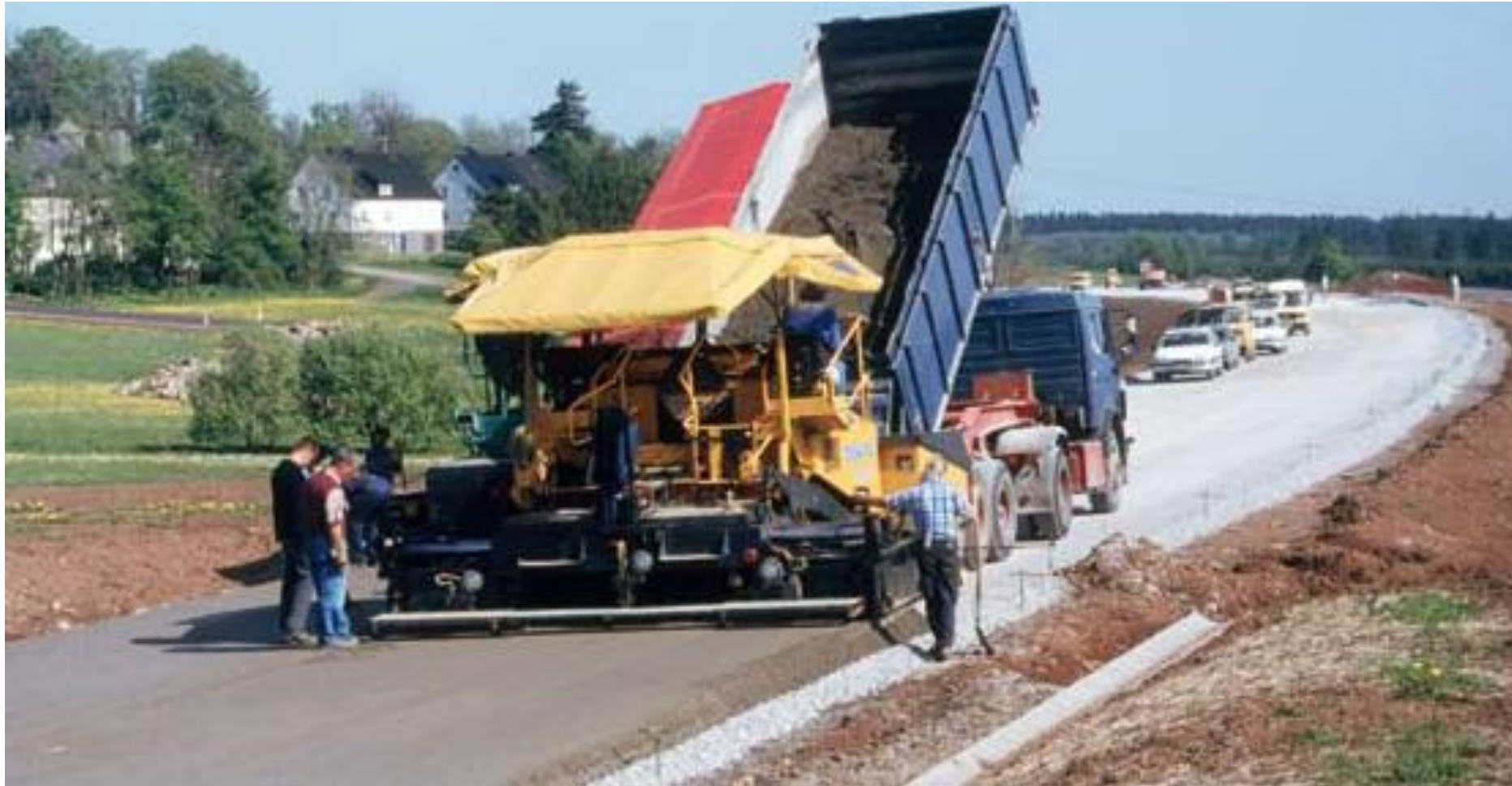
Nawierzchnia drogi B54 w Westerwald
