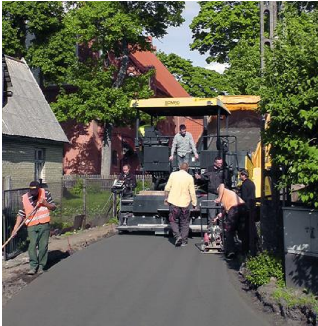
Rozściełacz BOMAG BF800C w trakcie układania nawierzchni z betonu wałowanego (źródło: Firma Harat S.J.).
