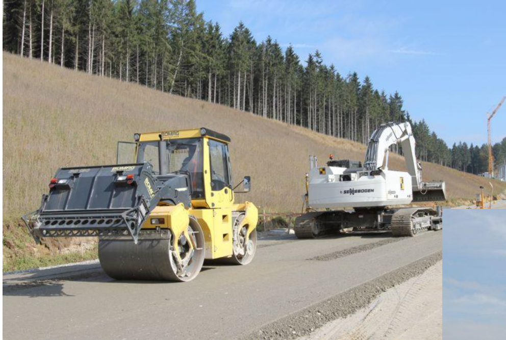
Autostrada A9 – okolice Chemnitz, podbudowa zasadnicza – X 2012
