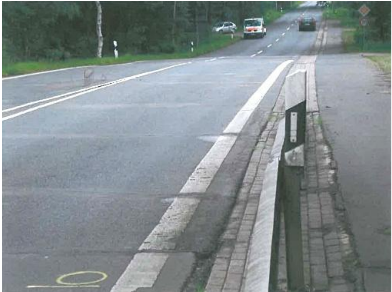
Istniejący stan drogi K 51
