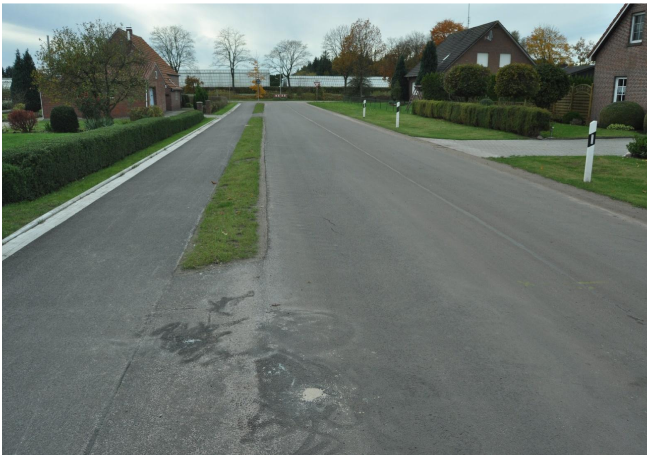
Ulica Drosselweg po 2 latach użytkowania – także poprzez ciężarówki z bardzo dużym obciążeniem
