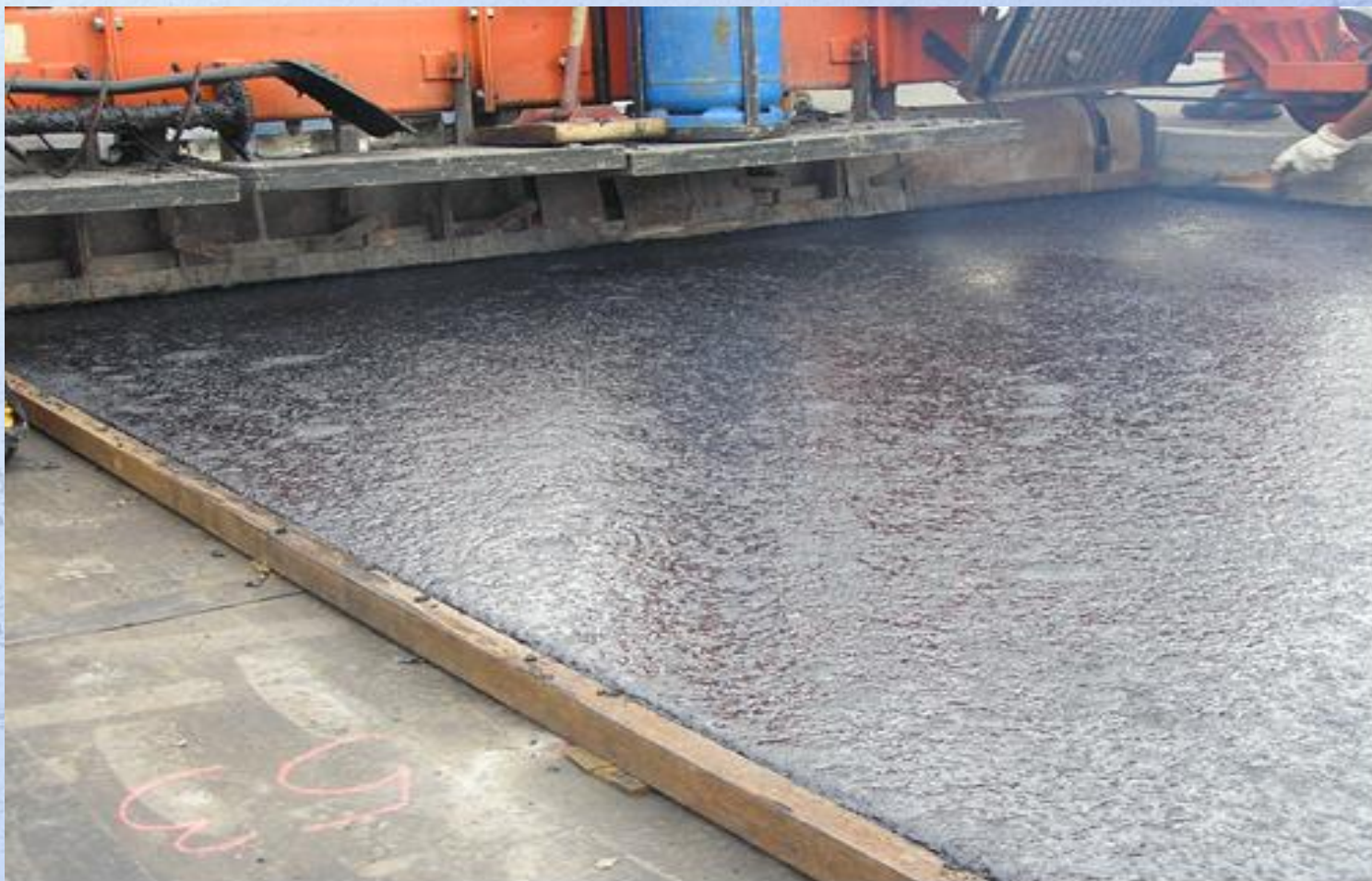
Układanie warstwy ochronnej
