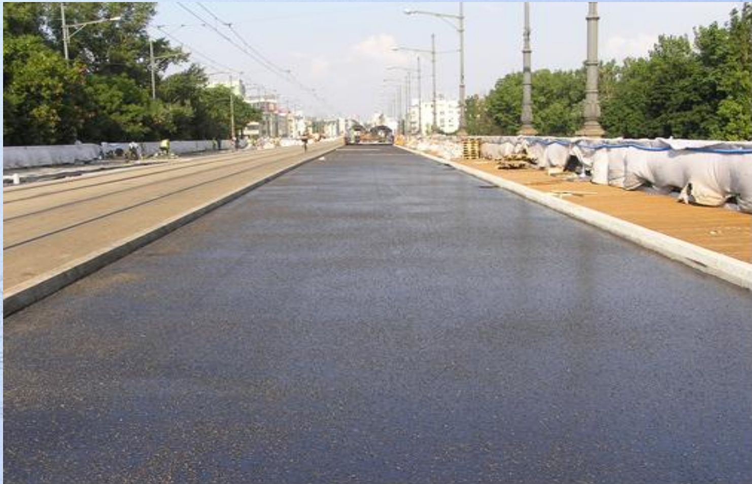
Układanie warstwy wiążąco-ochronnej
