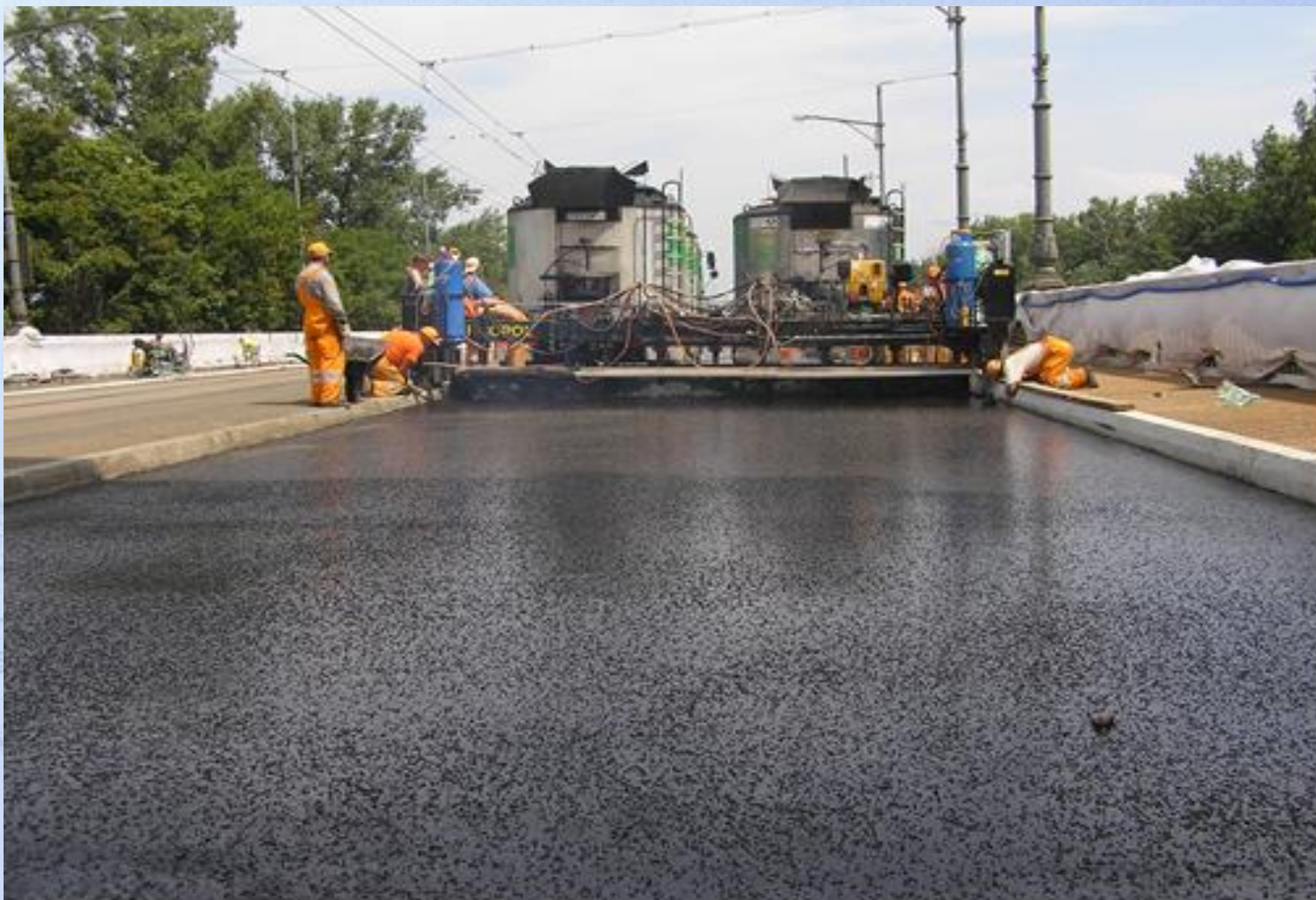
Układanie warstwy wiążąco-ochronnej
