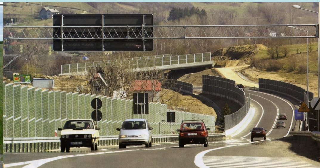
Początek drogi ekspresowej w Przybedzy. W tle widać przejście dla zwierząt
