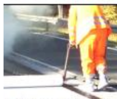
ów prowadzących bezpośrednio po spryskaniu podłoża
