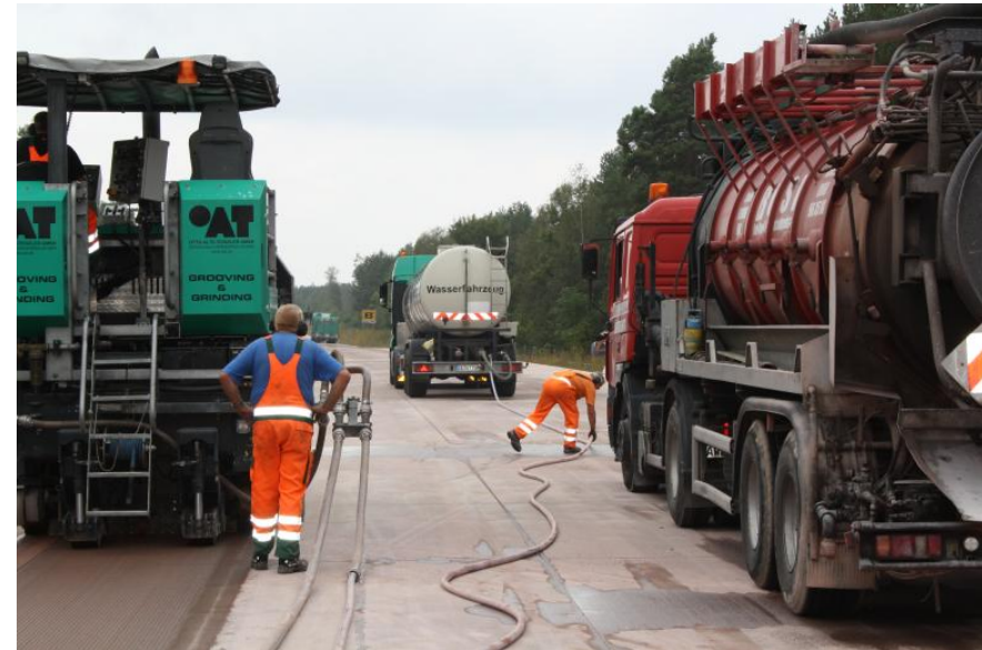
Zestaw maszyn do teksturowania powierzchni betonowej metodą „Grinding”
