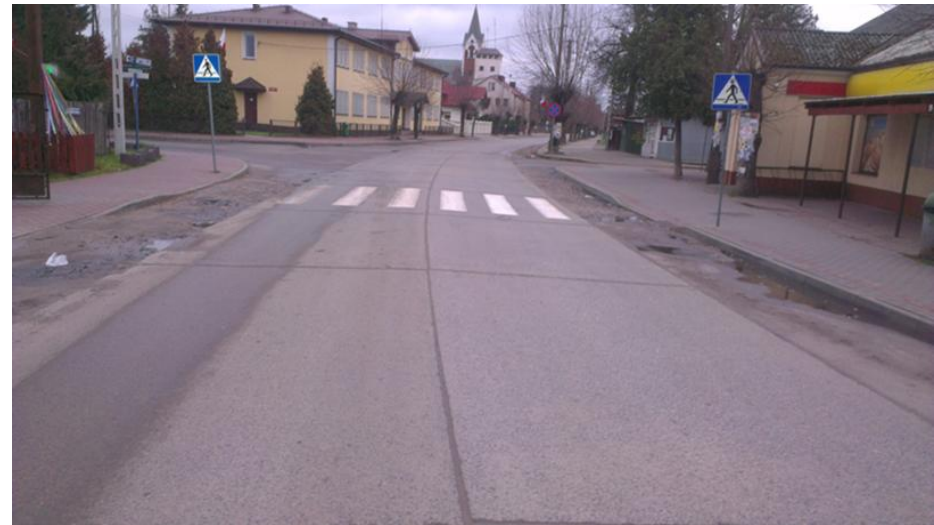
Widok nawierzchni betonowej w miejscowości Wilga po 55 latach eksploatacji Zdjęcie wykonane przez Wiesława Dąbrowskiego w dniu 11.11.2015
