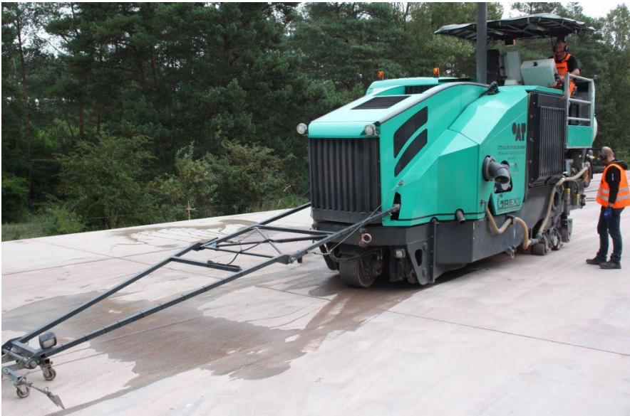
Zestaw maszyn do teksturowania powierzchni betonowej metodą „Grinding”
