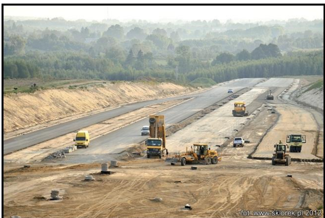
ODWODNIENIE KORPUSU DROGOWEGO, WYKONANIE PODBUDOWY I NAWIERZCHNI
