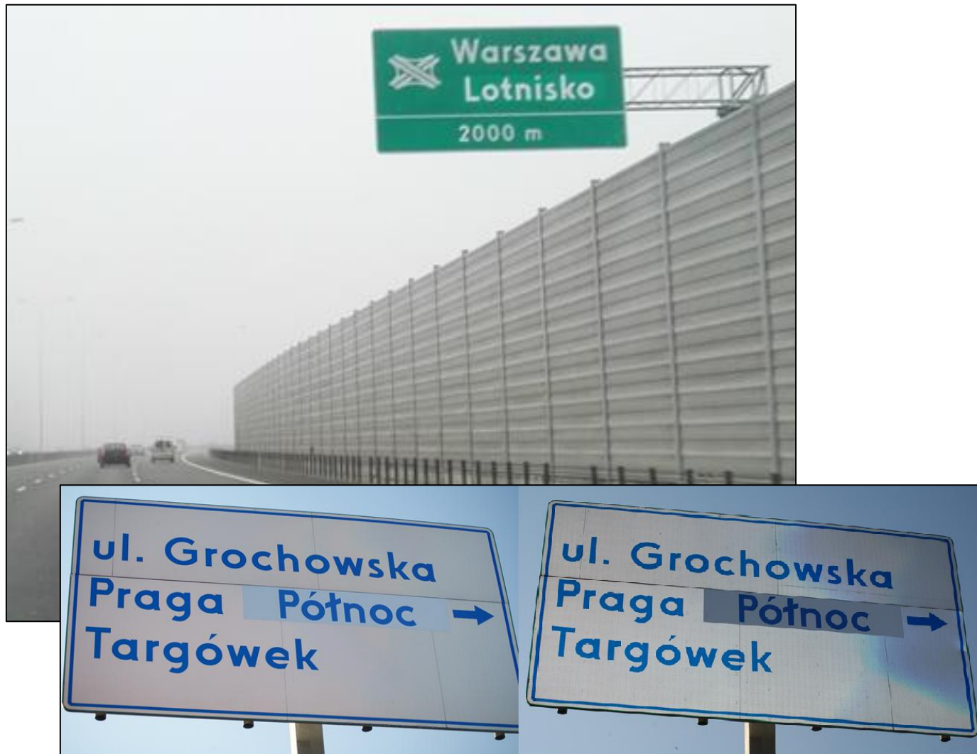
Znak E-20a wykonany z materiału II typu z wklejonym fragmentem z materiału III typu oraz znaki E-21 wykonane w technologii mikrokulkowej II typu z wklejonym fragmentem z materiału typu I
