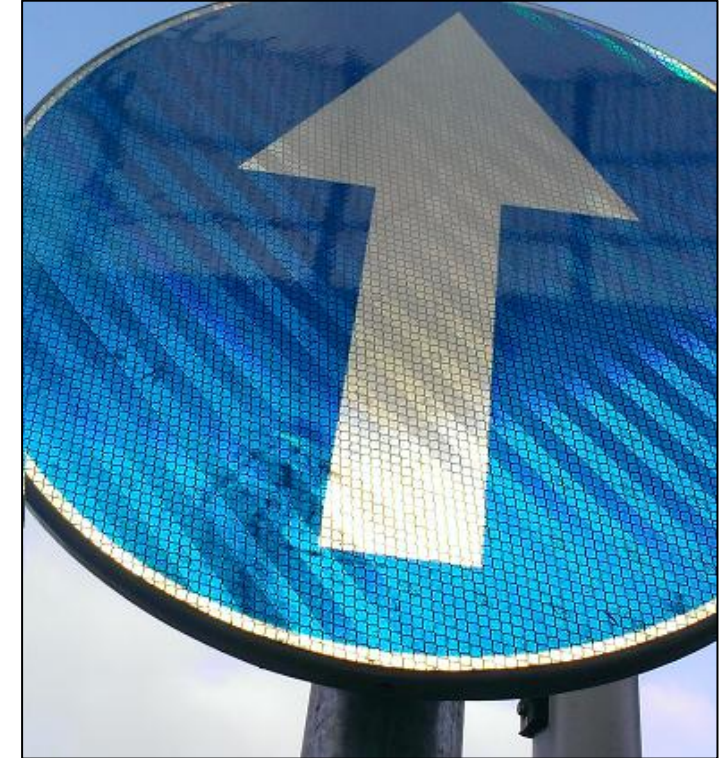
Znak C-5 wykonany z mikropryzmatycznej folii odbłaskowej I typu
