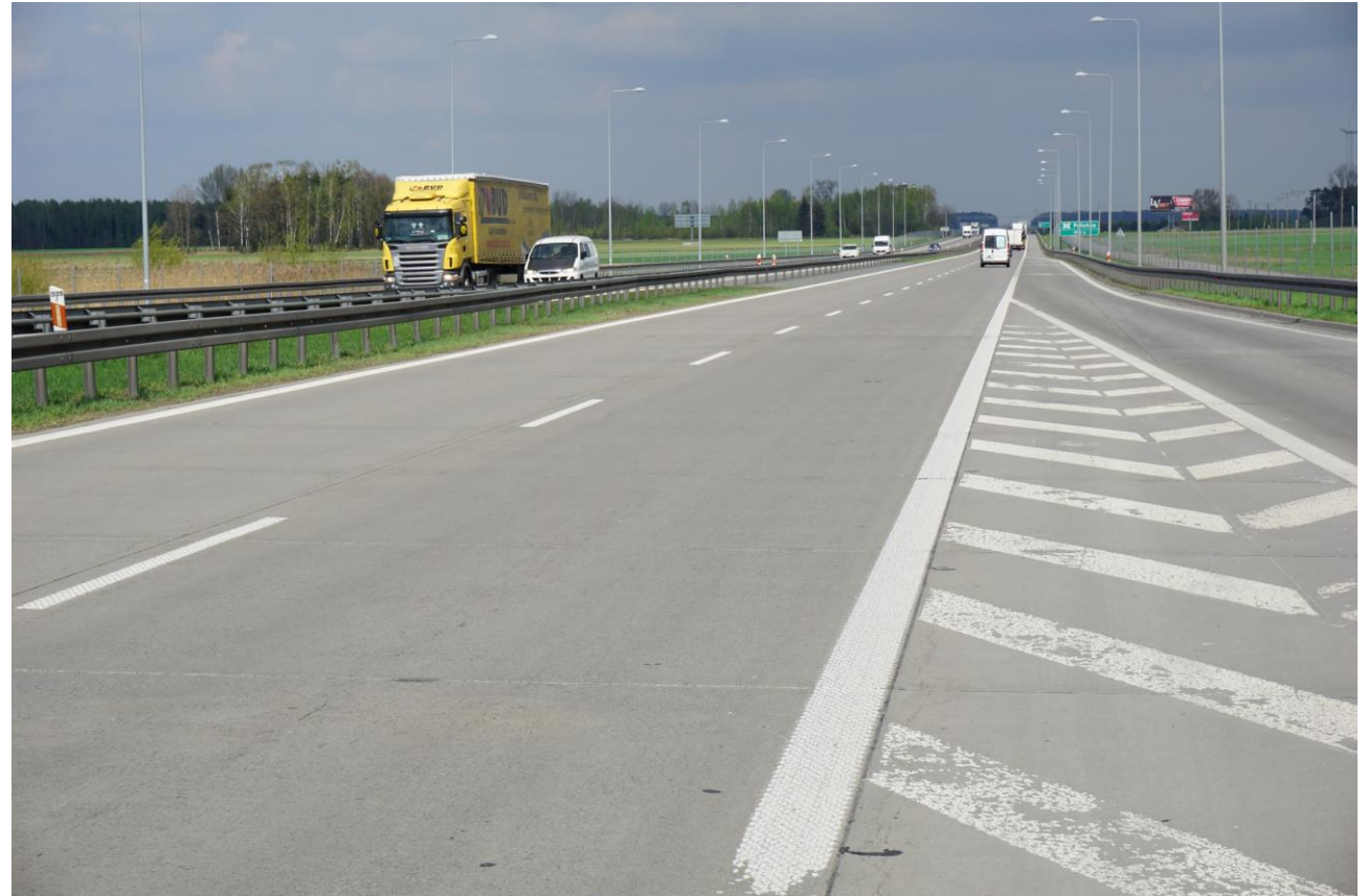
Nawierzchnia dyblowana na drodze ekspresowej KR6 po 15 letniej eksploatacji
