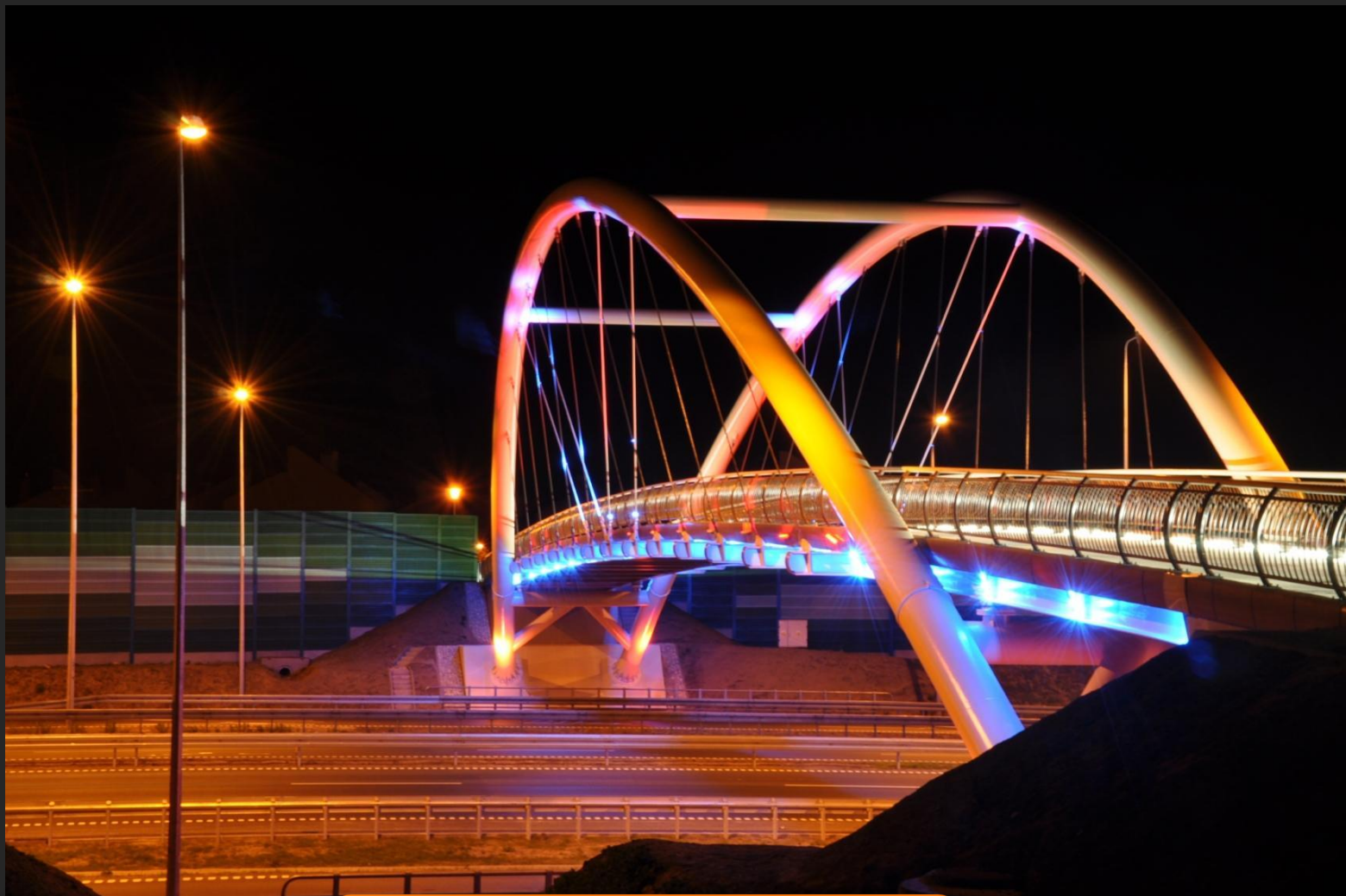
Iluminacja kładki dla pieszych
