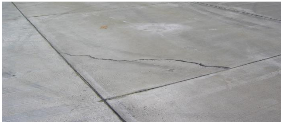
Pęknięcie w narożu
